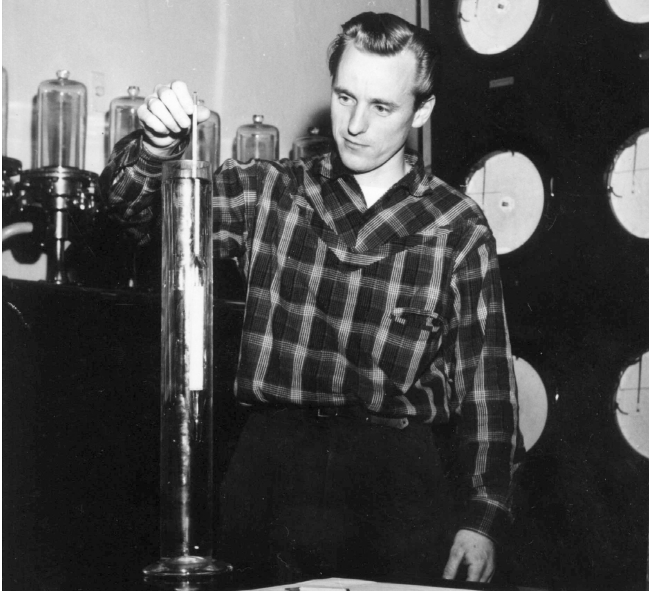
Det har alltid vært viktig for Vinmonopolet at produktene vi selger kjennetegnes av kvalitet – her fra Vinmonopolets rektifikasjonsanlegg på Hamar, hvor norsk-produsert potetråsprit blir redestillert til 96 prosent. Mannen på bildet kontrollerer tettheten i spriten for å kunne beregne eksakt alkoholinnhold, ca. 1950.
