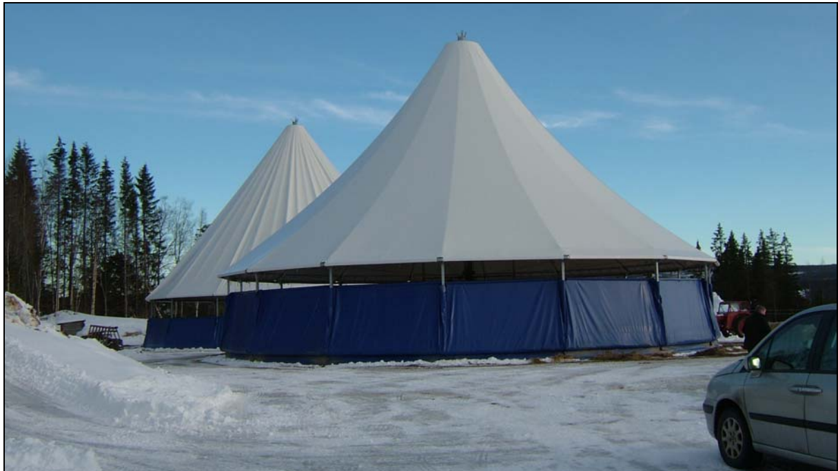
Sauefjøs i form av plasttelt, Undersåker i Jämtland.
