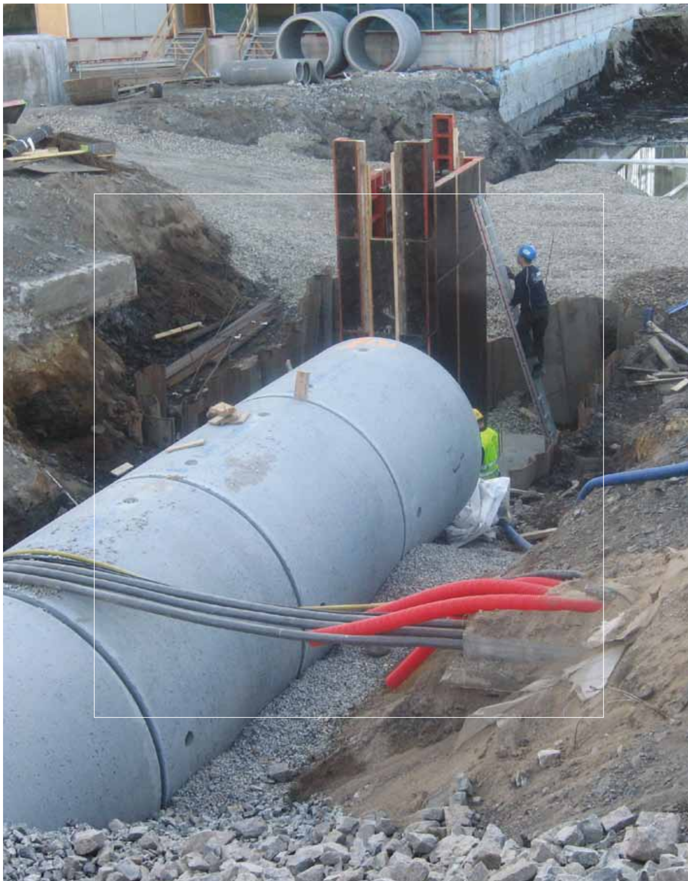
Foto: Norconsult, 3.Ledningsanlegg Hovinbekken, Midtgaardssormen, Oslo
