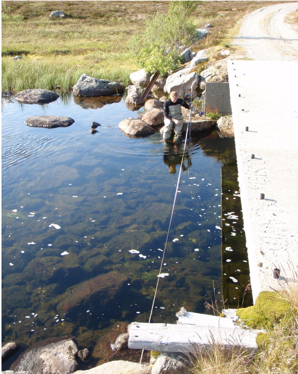
Måling ved Beinskjer Bru. Vannstandslogger er plassert under brua.
