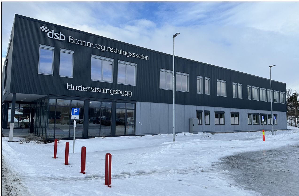
Figur 8.1 Det nye undervisningsbygget til Brann- og redningsskolen i Tjeldsund.
