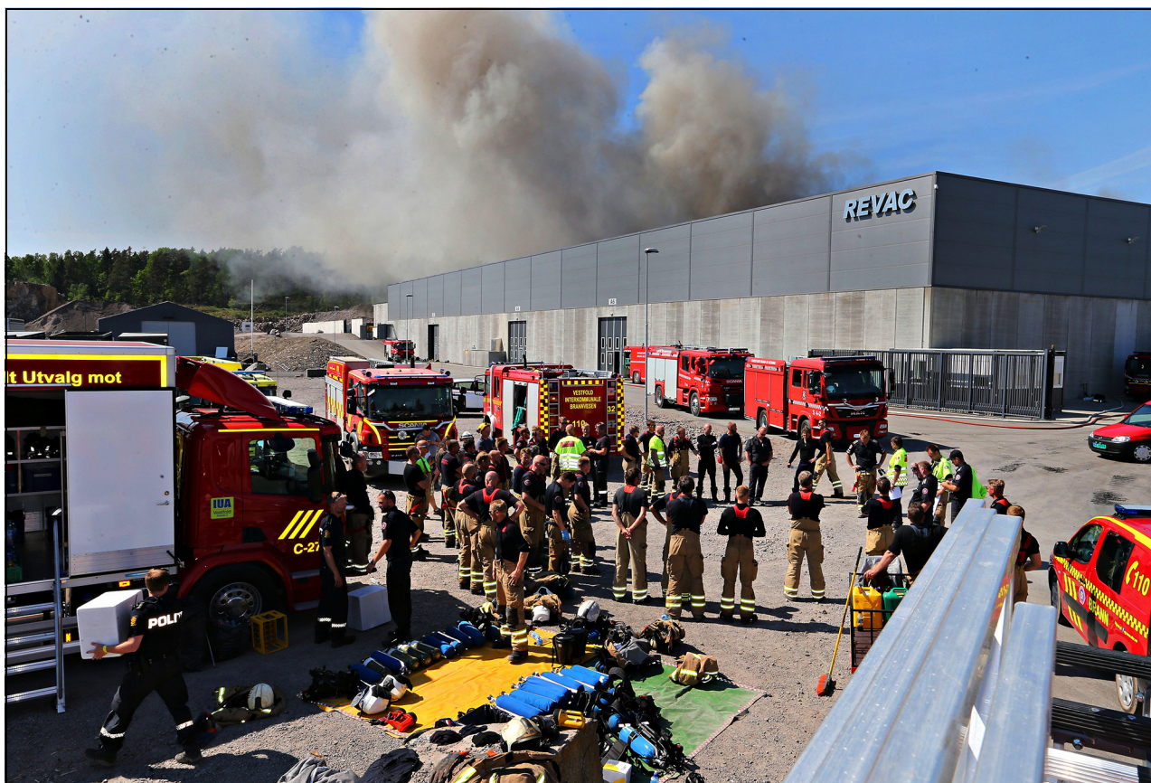
Figur 7.5 Brann i Revacs avfallsanlegg på Revetal i Vestfold i 2018.
