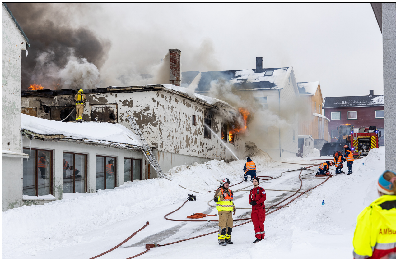
Figur 6.1 Bygningsbrann i Vardø sentrum i 2022.
