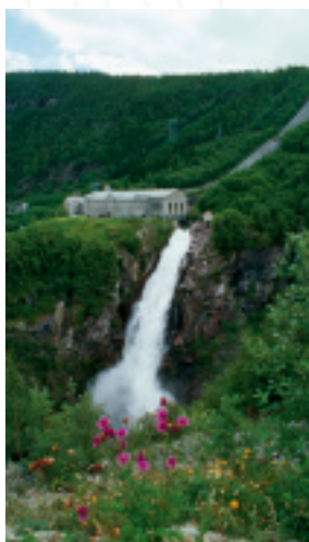
De store vannkraftprosjektene tid er over, men mange kraft- stasjoner er monumentale bygg som gjenspeiler vannkraftens historiske betydning for norsk næringsliv og samfunn. Gamle Vemork kraftstasjon, Rjukan i Telemark, er nå Norsk Industriarbeidermuseum.
