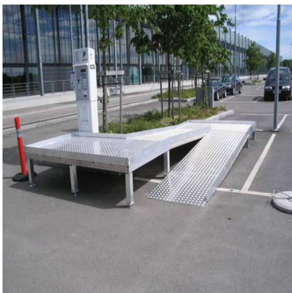
En komplisert løsning er valgt for å gi tilgjengelighet for rullestolbrukere.
