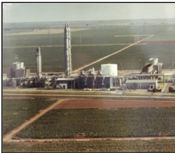
1. generasjon fullskala CO 2 -renseanlegg fra kraftverk. Lubbock Texas 1980. ~0,4 mill tonn CO 2 til EOR.
