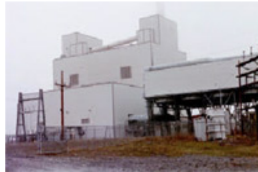
Warrior Run – Kullkraftverk med CO2-fjerning
