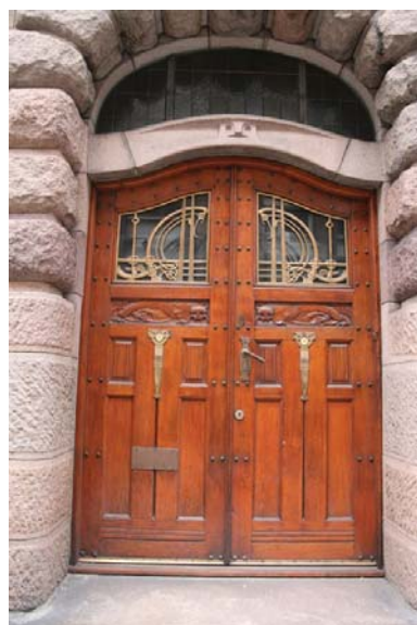
Inngangsdøren fra Grubbegata er ikke i bruk i dag. Opphavsrett: Statsbygg.
