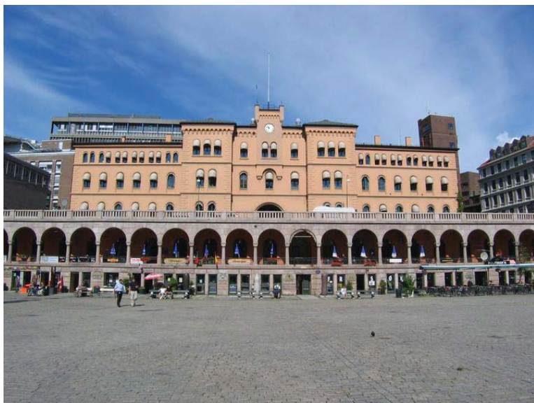
Bildet viser Møllergatas monumentale fasade sett fra Youngstorget i retning vest. På nedsiden av bygget ser man de karakteristiske basarene som tar opp høyden ned til torget. Opphavsrett: Statsbygg.
