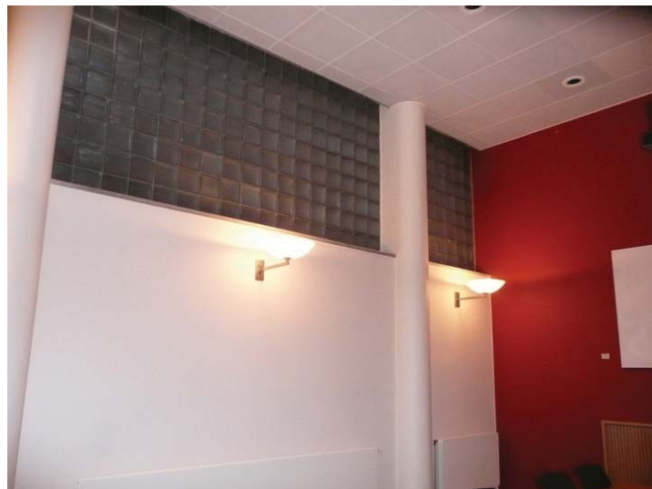
1. etasje. Tidligere rettsal. Glassbyggerstein i øvre veggparti. Opphavsrett: Statsbygg.
