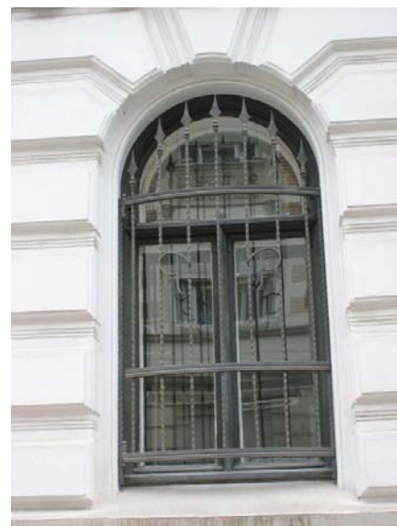
Vinduene med smijernsgitter og PP med henvisning til Peter Petersen. Opphavsrett: Statsbygg.
