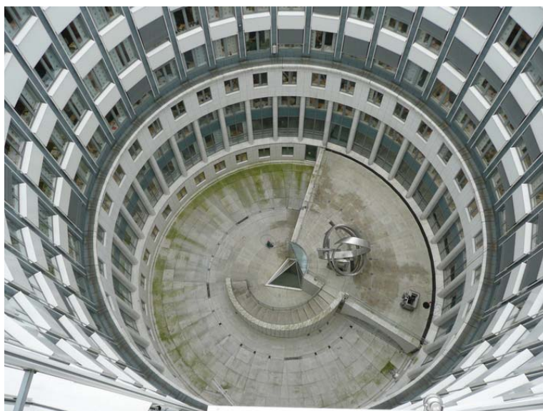
Den største av lysgårdene i R-5. Opphavsrett: Statsbygg.
