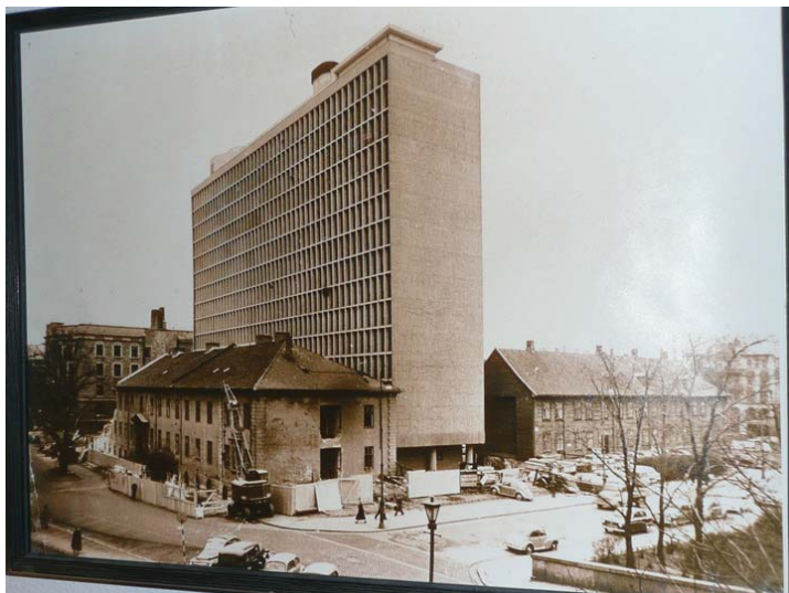
Høyblokken under oppføring. Rikshospitalets gamle bygninger er ennå ikke revet. Opphavsrett: Statsbygg.
