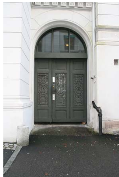
Detaljer på rehabilitert ytterdør. Opphavsrett: Statsbygg.
