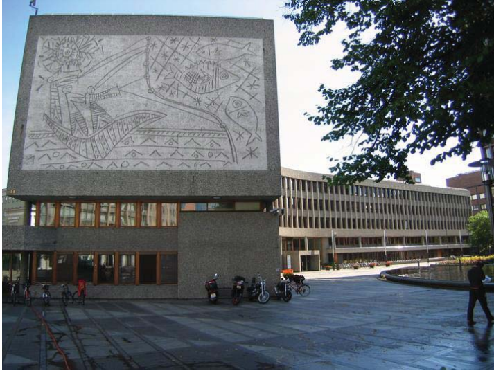
Bildet viser sørgavlens ende av den ene armen på det stjerneformede bygget. Til høyre ser man bygget krumme seg rundt Høyblokka mot øst. Det sandblåste kunstverket "Fiskerne" er tegnet av Pablo Picasso og utført av Carl Nesjar. Opphavsrett: Statsbygg.
