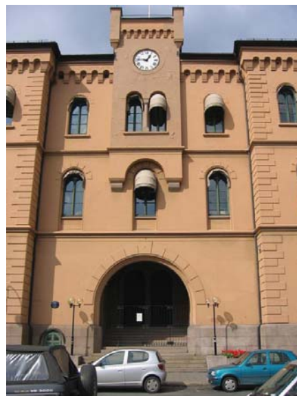
Bildet viser midtpartiet, med hovedinngangen mot Youngstorget. Opphavsrett: Statsbygg.
