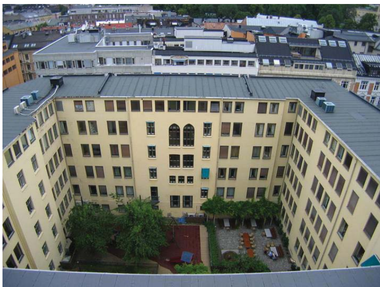
Bakgården sett fra taket. Opphavsrett: Statsbygg.
