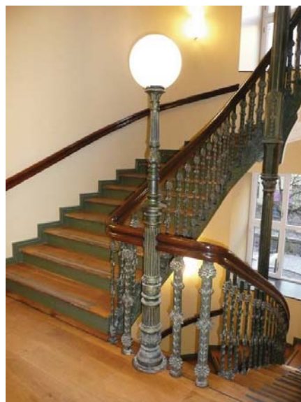
Hovedtrapp med støpejernsrekkerkverk. Opphavsrett: Statsbygg
