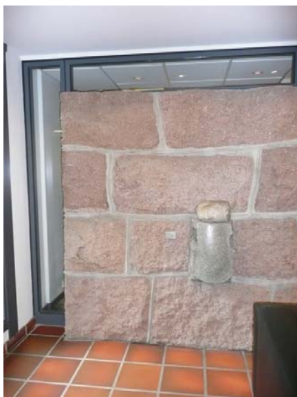
Rester av den gamle fengselsmuren er bevart i resepsjonen. Opphavsrett: Statsbygg.
