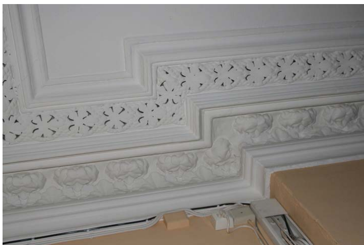
Opprinnelig taklist. Opphavsrett: Statsbygg.
