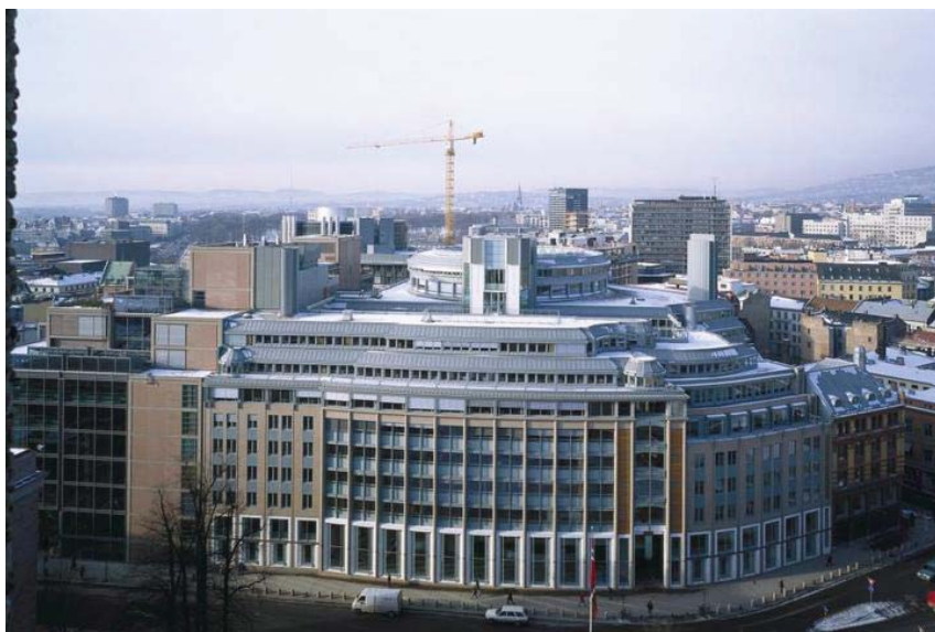
R5 - Oversiktsbilde sett fra Høyblokka. Opphavsrett: Jiri Havran.
