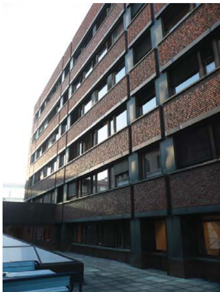
Stram fasade mot Møllergata 19. Sidelyset understreker relieffvirkningen. Opphavsrett: Statsbygg.
