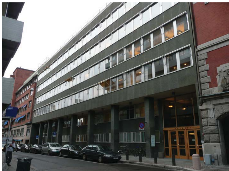
Eksteriørbilde som viser den inntrukne 1. etasje og mezzanin som gir plass til søylearkaden mot gaten. Opphavsrett: Statsbygg.
