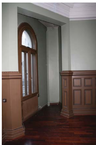
Originalt vindu og brystpanel fremhevet. Opphavsrett: Statsbygg.
