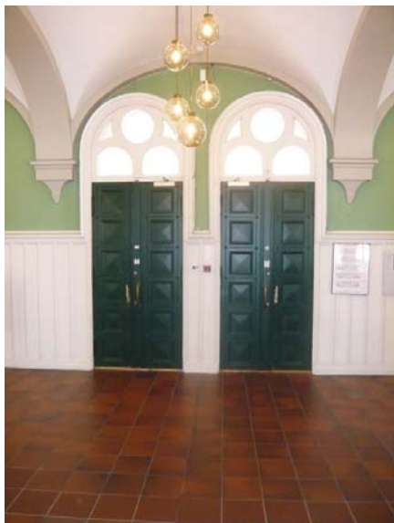
Hovedinngangen fra Møllergata sett fra innsiden. I dag er den stengt av. Opphavsrett: Statsbygg.
