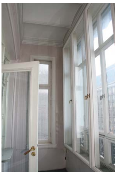
Doble vinduer mot syd og 3. og 4. etasje. Opphavsrett: Statsbygg.
