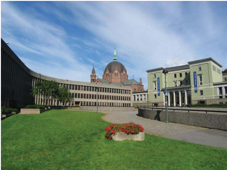
Bildet viser nordfløyen av Y-blokken til venstre i bildet. Deichmanske bibliotek til høyre og bakerst i bildet ligger Trefoldighetskirken. Området på denne nordøstlige siden av anlegget er enkelt opparbeidet. Opphavsrett: Statsbygg.
