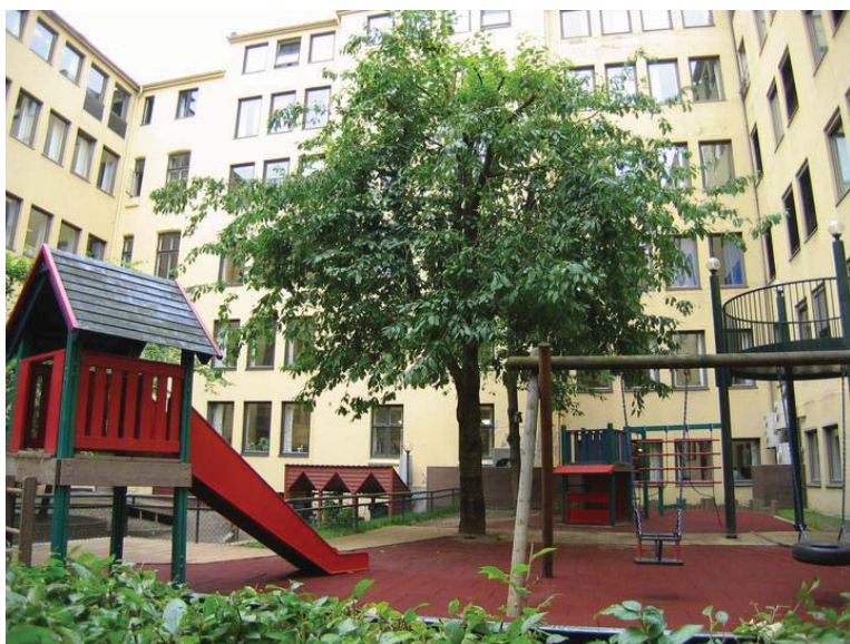
Fasader mot bakgården med barnehagen. Opphavsrett: Statsbygg.
