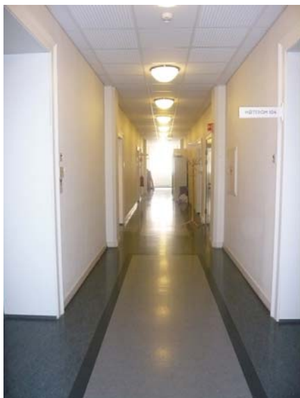
Kontorkorridor etter siste rehabilitering. Opphavsrett: Statsbygg.
