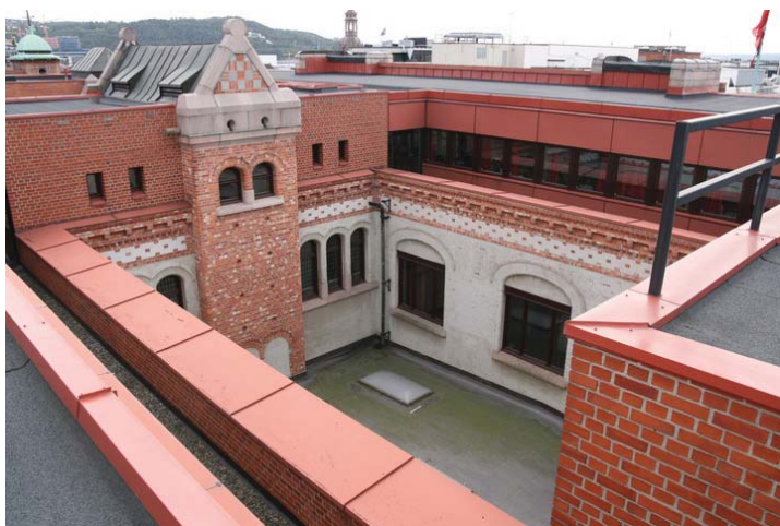
Ny toppetasje over hele bygningen ble bygget på i 1974-76. Opphavsrett: Statsbygg.
