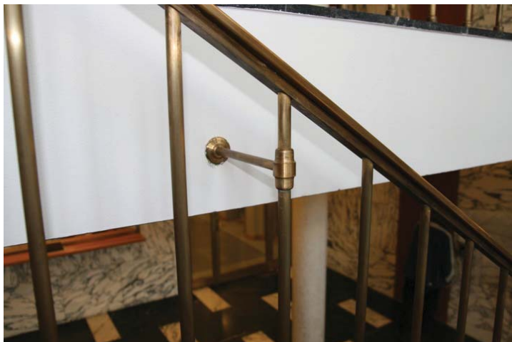
Detalj fra trappen i 1963-bygget. Opphavsrett: Statsbygg.
