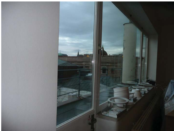
7. etasje. Original stårramme på vinduene i et kontor. Opphavsrett: Statsbygg.
