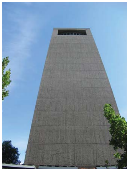
Bildet viser sør enden av Høyblokken, med sine karakteristiske sandblåste relieffer i betongmuren. Opphavsrett: Statsbygg.
