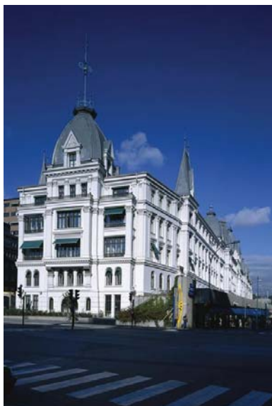
Sydkvartalet mot Løkkeveien. Foto: Opphavsrett: Jiri Havran.
