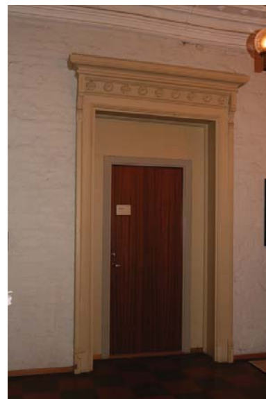
Ny dør i original karm. Opphavsrett: Statsbygg.
