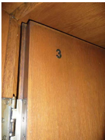
Messanin. Detalj med nummer på kontordør. Opphavsrett: Statsbygg.
