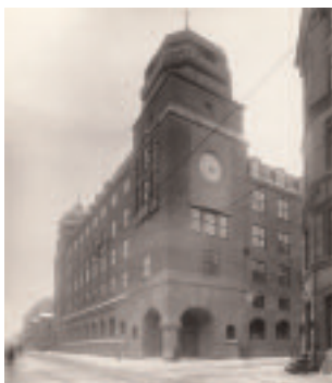
Det nye posthuset i Kristiania ble påbegynt i 1914 og var tegnet av Rudolf Emanuel Jacobsen. Foto: Skarpmoen. Copyright Riksantikvaren.
