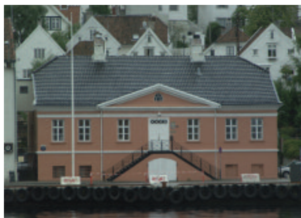
Tollboden i Stavanger. Tegnet av Christian Heinrich Grosch i 1840. Foto: Mariane Høstmark Tveter. Copyright Riksantikvaren.
