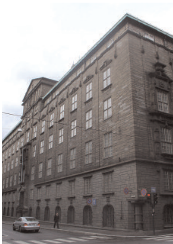
Telegrafvesenets nye bygning i Oslo var resultat av en arkitektkonkurranse i 1916 som ble vunnet av Magnus Poulsson og Arnstein Arneberg. Foto: Tarja Koskinen.
