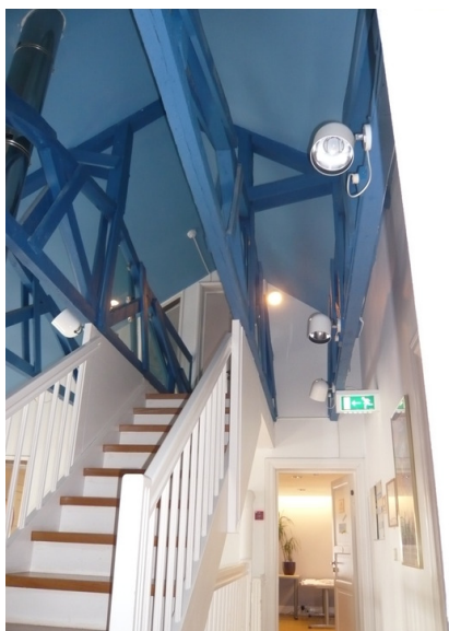
Trapp til 3. etg. Opphavsrett: Statsbygg.
