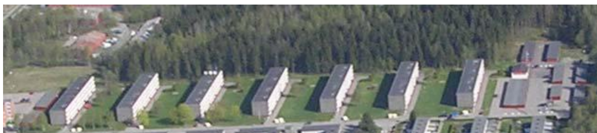
Bilde 2.1: Myhrerenga borettslag med 168 leiligheter blir sannsynligvis Nordens første rehabilitering med passivbyggkomponenter.
