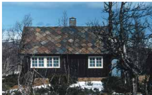
Skifer gir et solid inntrykk, og kan være et godt takmateriale som passer inn i naturen.
