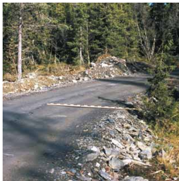
Nyanlagt og ikke helt ferdig veg. Vegetasjonen godt skånet i innersvingen
