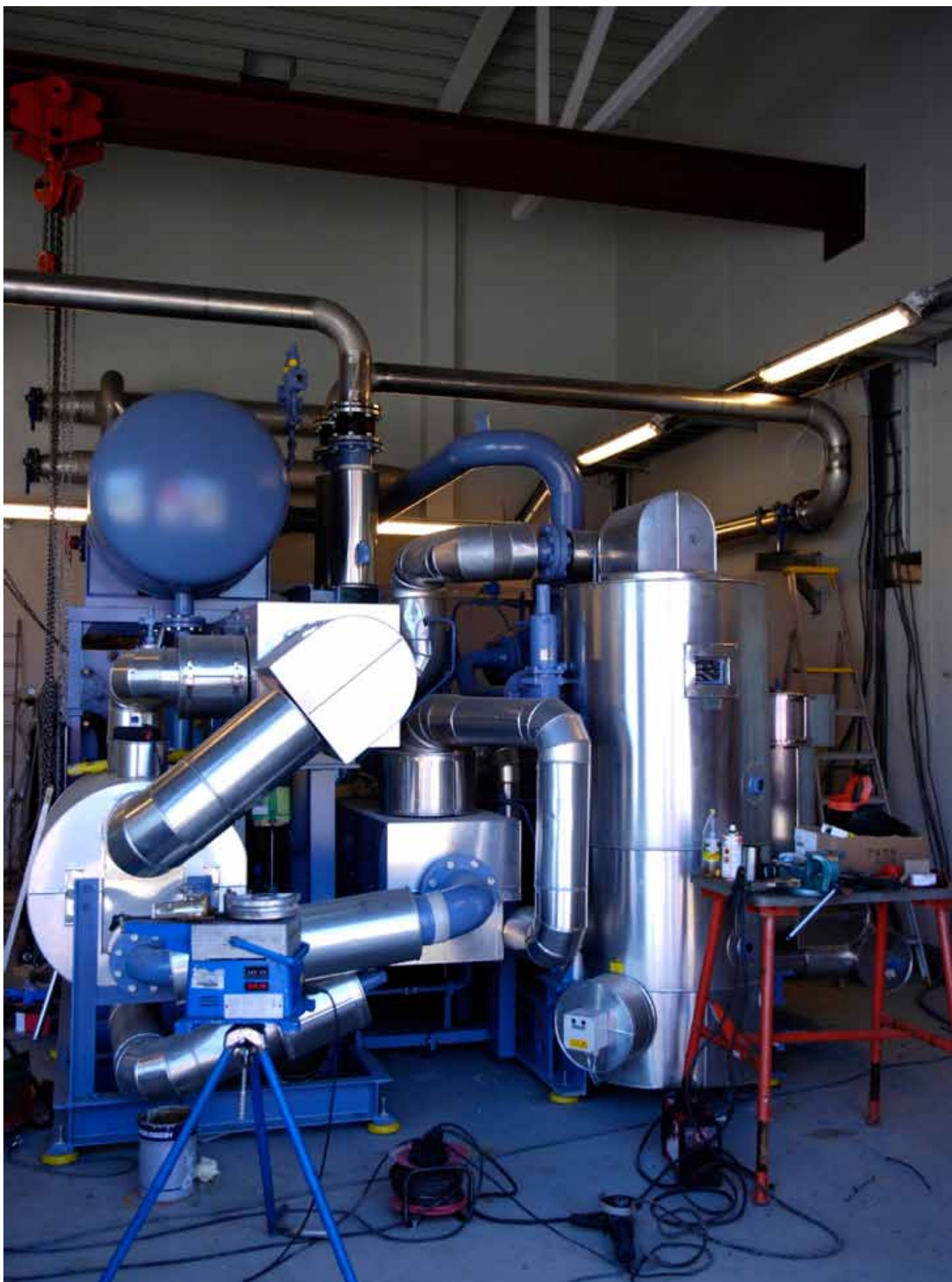
I varmesentralen til Biovarme AS står nå Norges største varmepumpe for industriell spillvarme samt en biokjel, også den siste basert på fornybare varmekilder. Varmesentralen til fjernvarmeselskapet er lokalisert på Borregaards område. Bildet viser anlegget under oppføring.
