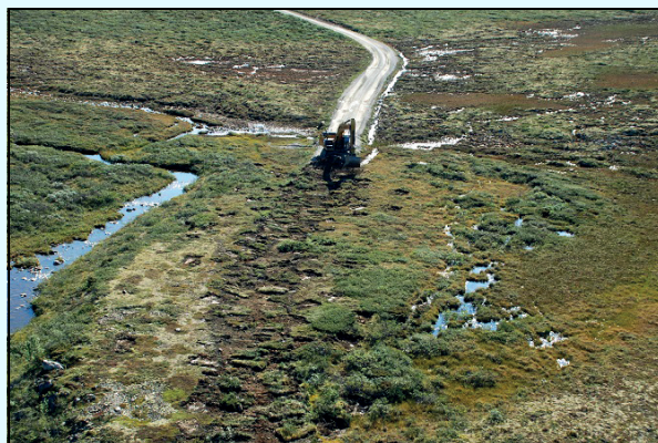
Figur 4.21 Gravemaskin spiser seg innover HFK-vegen Hjerkinnskytefeltet
