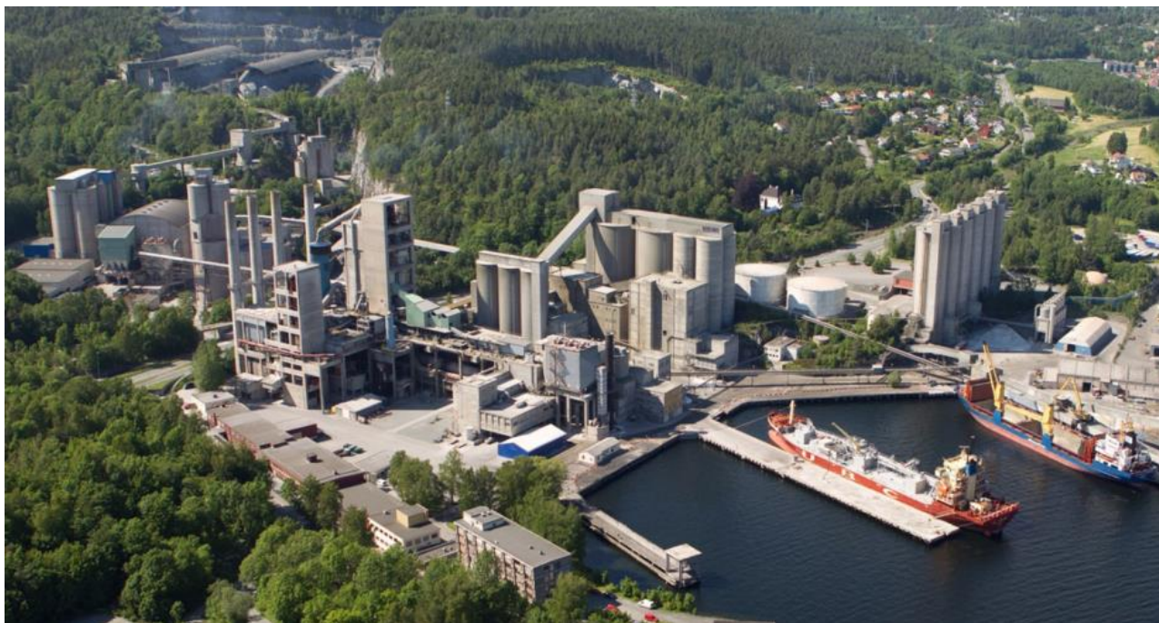
Figur 4-4: Norcem sin sementfabrikk i Brevik. Bilde: Norcem.
