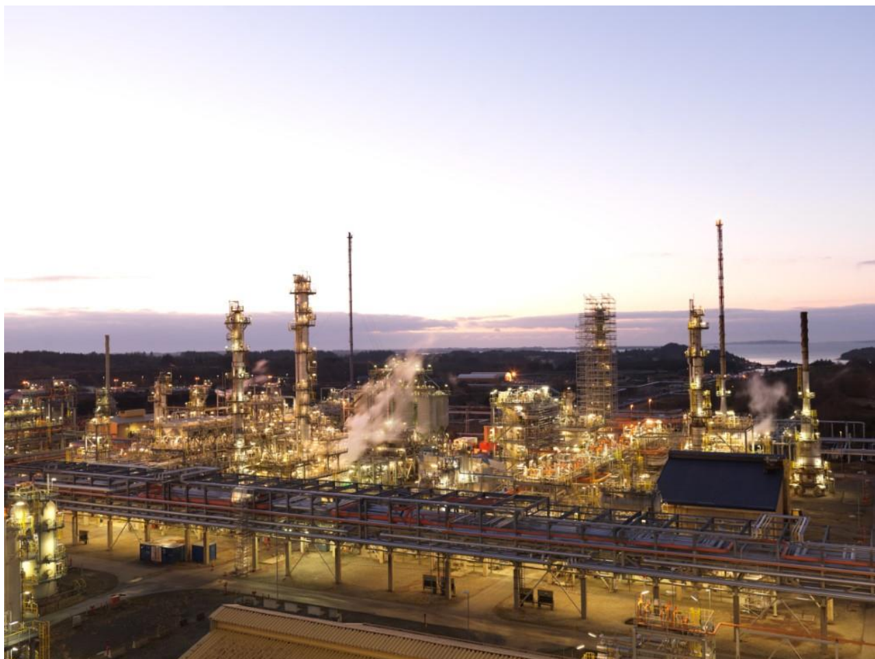
Figur 4-3: Raffineriet på Mongstad. Bilde: Øyvind Hagen - Equinor
