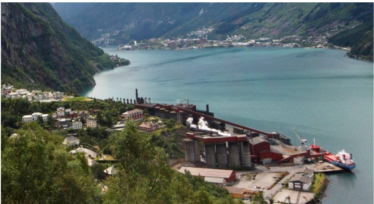
Figur 4-7: TiZir titandioksidsmelteverk i Tyssedal. Bilde: TiZir.
