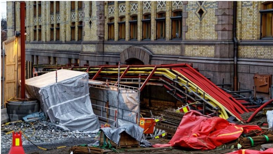
Da Stortinget fikk nytt postmotak og innkjøring dukket det opp en rekke kabler som ingen visste hvem eide, hvor de kom fra, eller hvor de gikk hen. Det bød på ekstra utfordringer å finne en sikker og midlertidig føring av disse. (Foto: Joachim Seehusen)
