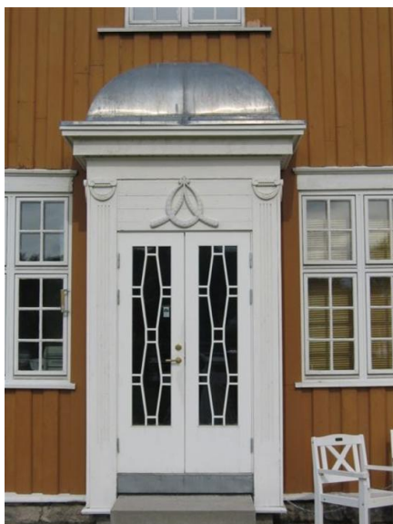
Detalj dør, utgang mot hagen og sjøen - fasade øst. Opphavsrett: Statsbygg.
