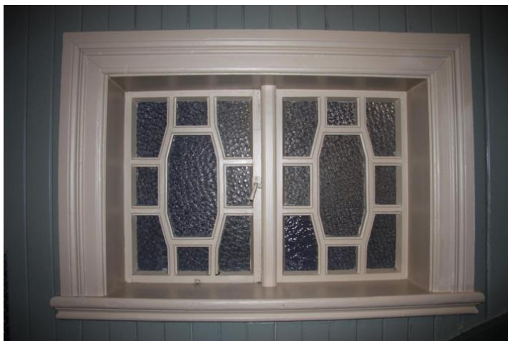
Vindu i trappeoppgangen. Utformingen er et dekorativt element i fasaden mot gaten. Opphavsrett: Statsbygg.
