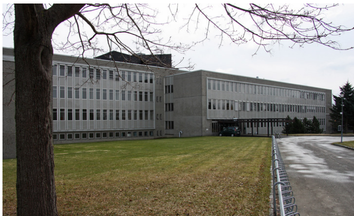
Hoovedinngang. Fasade mot vest. Opphavsrett: Statsbygg.
