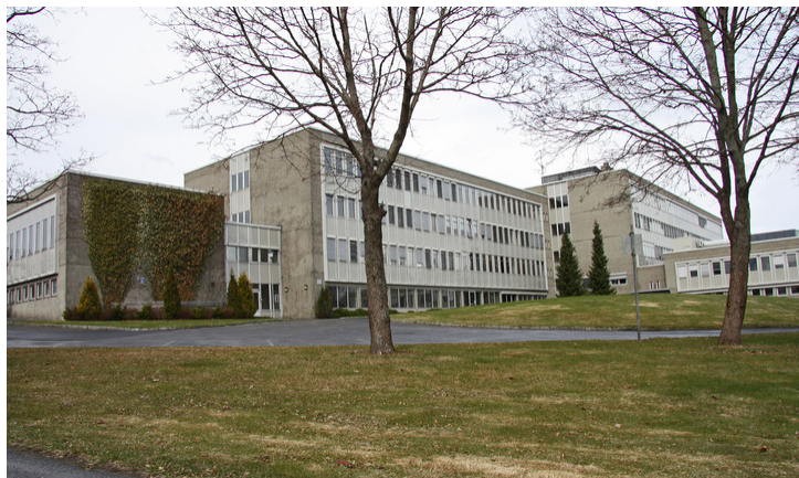
Fasader mot øst. Opphavsrett: Statsbygg.
