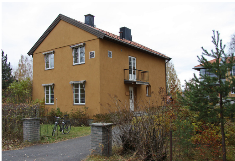
Fasade mot nord og øst. Opphavsrett: Statsbygg.
