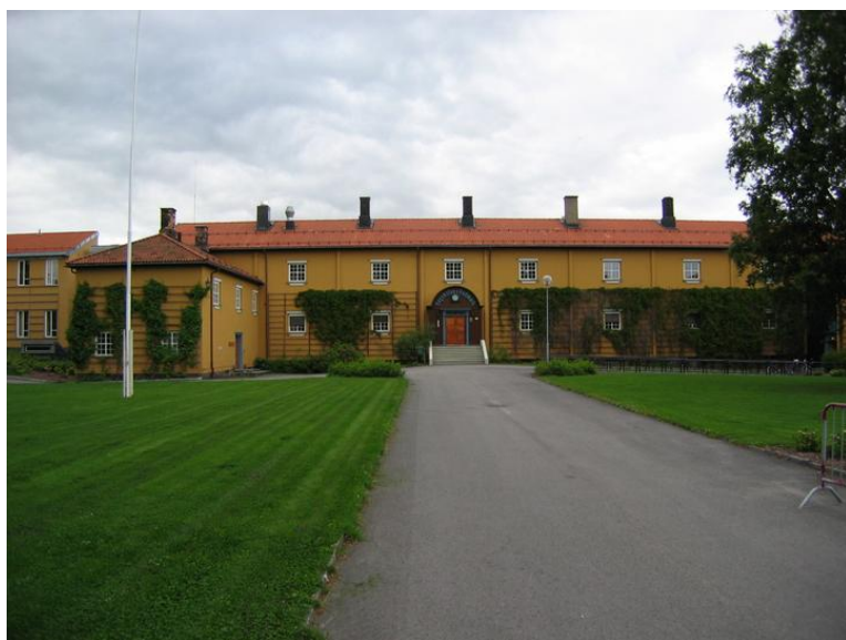
Fasade mot øst med fløy H mot nord, til venstre. Opphavsrett: Statsbygg.
