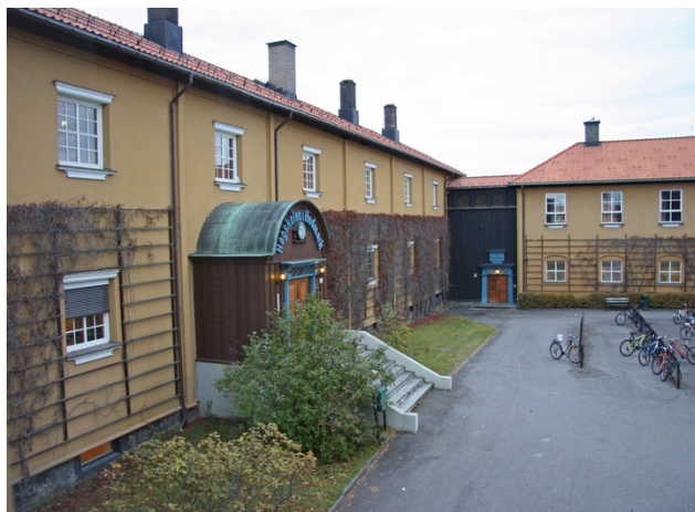
Blokk A fasade øst sett mot Blokk B, med Hovedinngang. Opphavsrett: Statsbygg.
