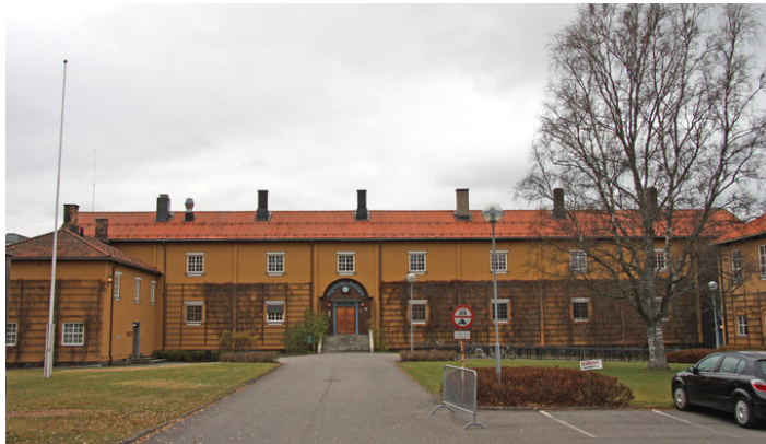
Hovedadkomsten. Opphavsrett: Statsbygg.
