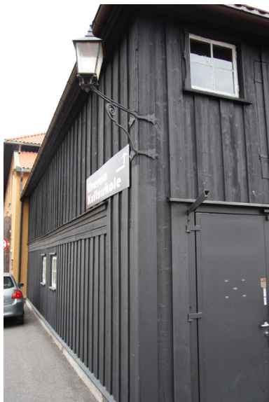
Opprinnelig var fasaden t.v. mot syd, i 1. etasje åpen, trolig som uværsskur. Opphavsrett: Statsbygg.
