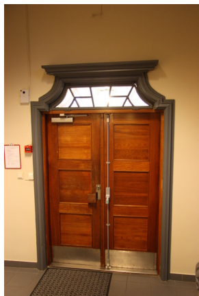
Inngangsdør Opphavsrett: Statsbygg
