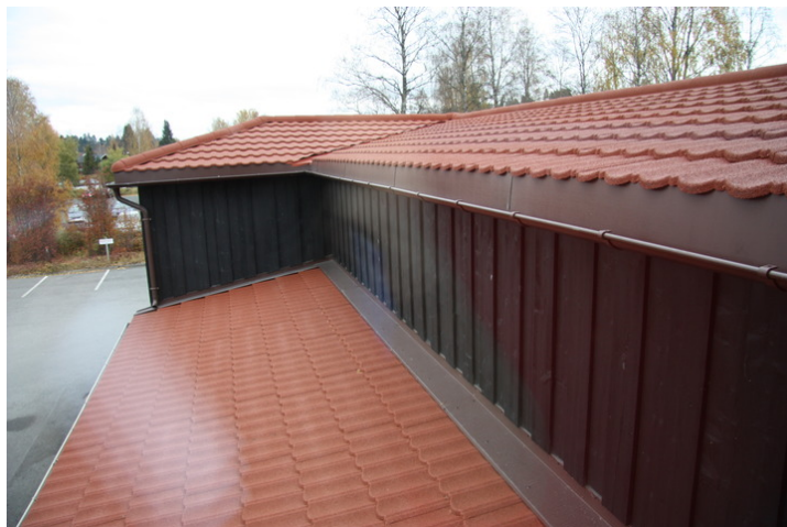
Detlj av tak, sett mot øst Opphavsrett: Statsbygg.
