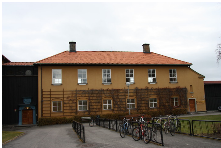
Fasade mot syd m/ inngang. Opphavsrett: Statsbygg
