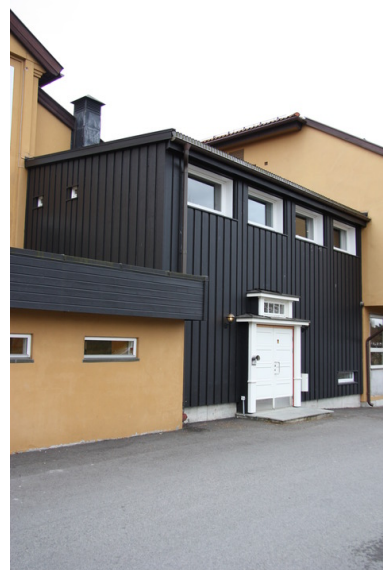
Inngangsparti for aulaen. Opphavsrett: Statsbygg.
