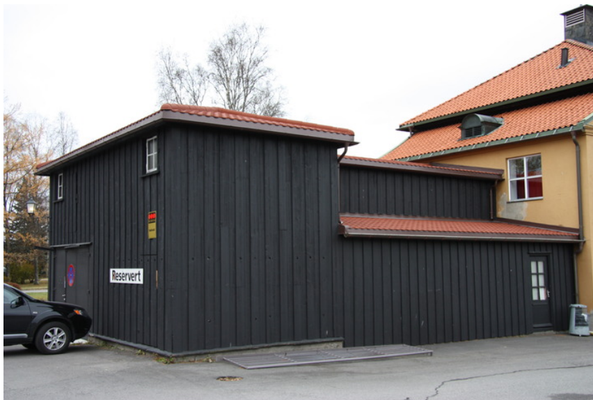
Fasade mot nord, Blokk B til venstre. Den lave delen antas tilbygd senere. Opphavsrett: Statsbygg.
