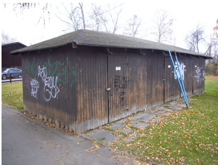
Lagerbygning ved gymnastikkanlegget. Opphavsrett: Statsbygg.
