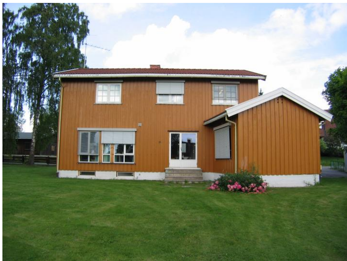
Fasade mot syd. Opphavsrett: Statsbygg.
