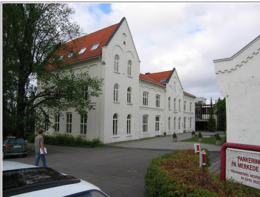
Nils Hertzbergs hus (A-bygningen). Opphavsrett: Statsbygg.
