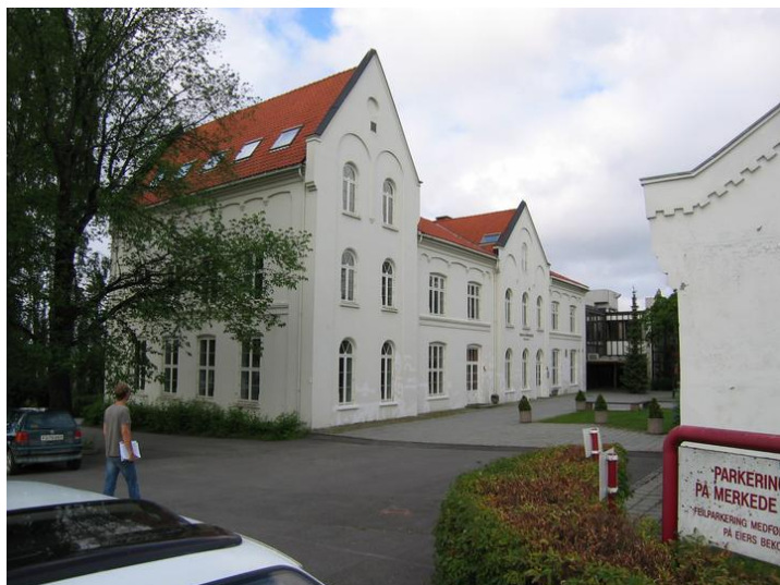
Nils Hertzbergs hus (A-bygningen). Opphavsrett: Statsbygg.
