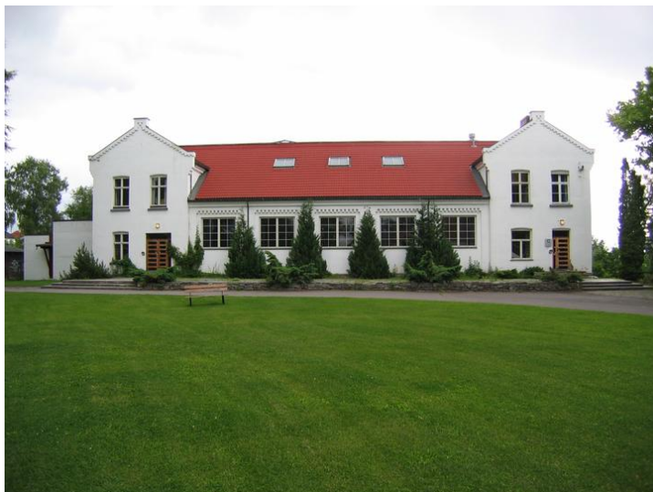
Fasade mot syd Opphavsrett: Statsbygg.
