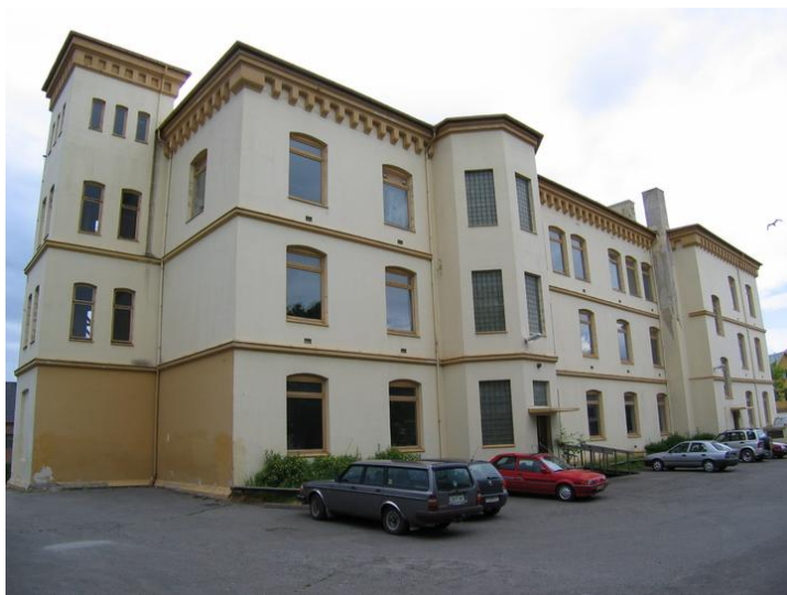
Fasade mot øst. Opphavsrett: Statsbygg.
