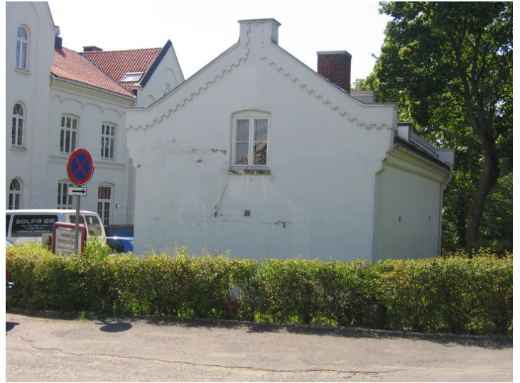
Fasade mot øst. Opphavsrett: Statsbygg.
