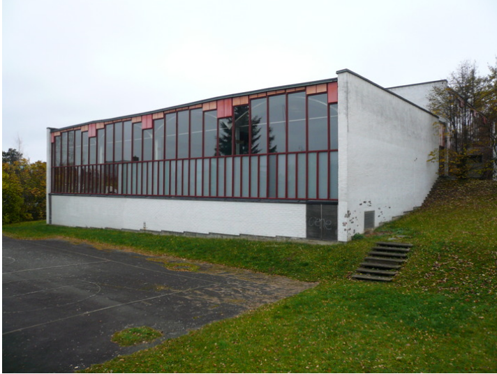
Fasade øst. Opphavsrett: Statsbygg.
