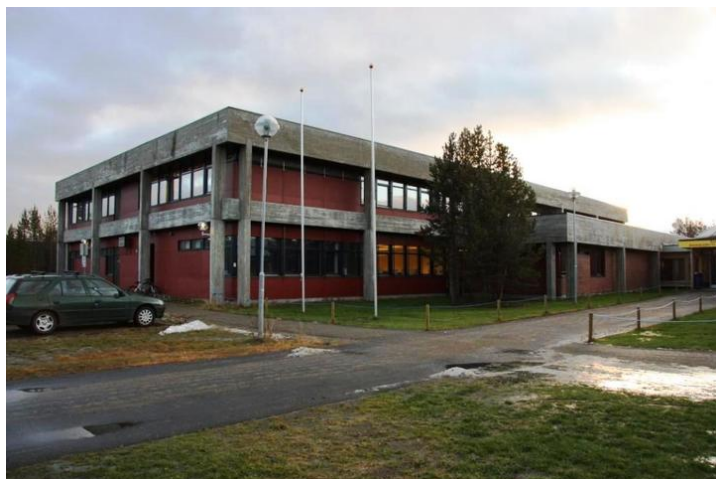
Byggetrinn 1, 1979. Klasserommet for kjemi er i 2. etasje helt til venstre i bildet. Opphavsrett: Statsbygg.
