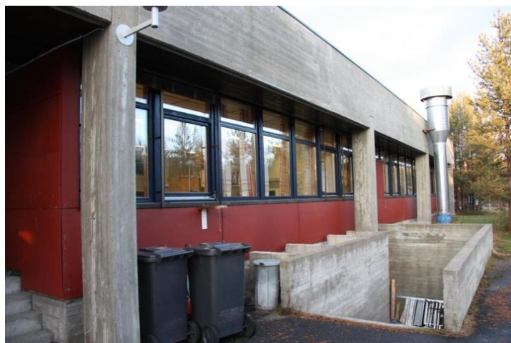
Del av fasaden mot øst med nedgang til underetasjen. Opphavsrett: Statsbygg.
