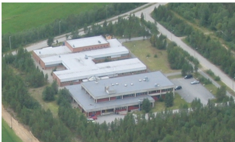
Flyfoto som viser begge byggetrinnene og hvordan de er koplet sammen. 1.byggetrinn foran i bildet. Opphavsrett: Statsbygg.
