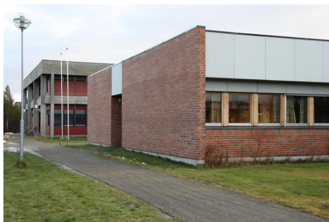
Karasjok videregående skole. 1. byggetrinn til venstre i bildet. Opphavsrett: Statsbygg.
