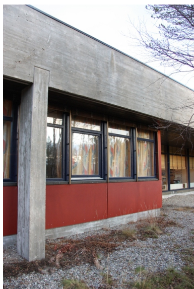
Det av fasaden mot syd. Opphavsrett: Statsbygg.
