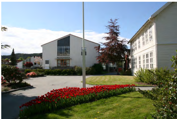
Annekset ligger mot plassen mellom hovedbygningen og 1960-anlegget. Opphavsrett: Statsbygg.
