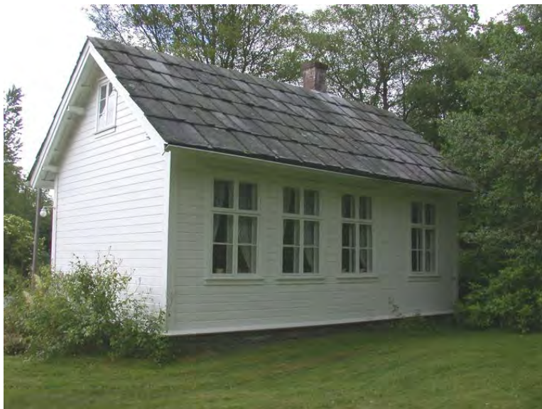
Fasade sørvest. Opphavsrett: Statsbygg.
