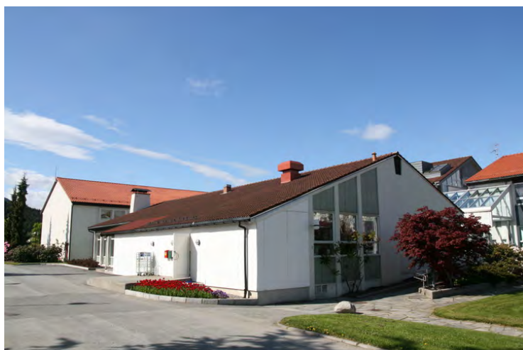
Det nærmeste hjørnet er ombygd, var opprinnelig en åpen overbygd inngang. Opphavsrett: Statsbygg.
