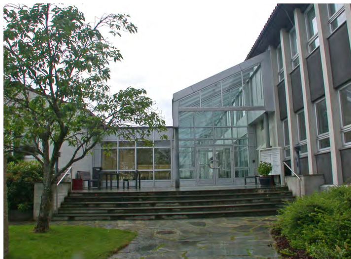
Partiet mellom Velferdsbygg og Spesialrombygg er endret. Trappeanlegg er oppført sammen med mellombygget fra 1994. Opphavsrett: Statsbygg.
