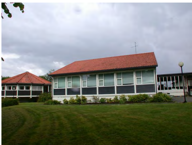
Fasade sørvest. Inngangsparti til høyre er senere endret. Opphavsrett: Statsbygg.
