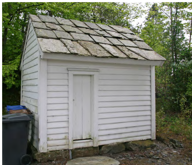
Uthus til skolestua omfattes også av vernet. Opphavsrett: Statsbygg.
