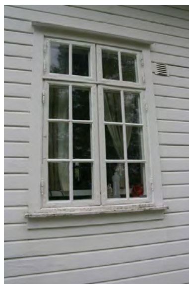
Krysspostvinduer. Opphavsrett: Statsbygg.
