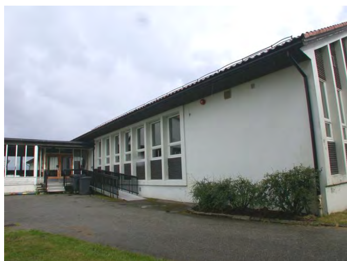
Opprinnelig fasade nordvest, senere er inngangsparti endret, nytt mellombygg oppført. Opphavsrett: Statsbygg.
