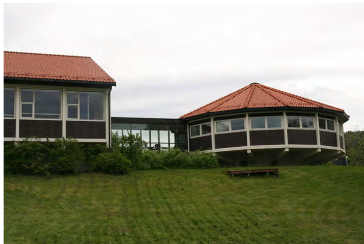
Mellombygget ses tydelig fra øst. Opphavsrett: Statsbygg.
