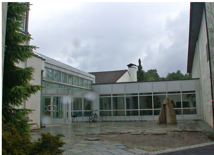
Inngangsparti fra 1994, til velferdsbygg. Opphavsrett: Statsbygg.
