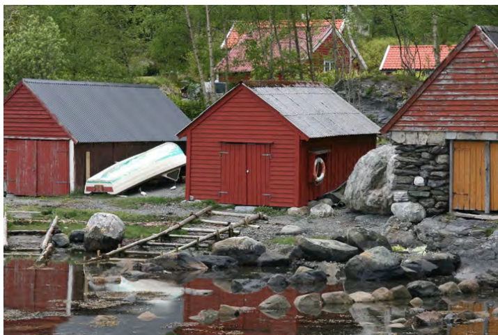
Naustet midt i bildet. Opphavsrett: Statsbygg.
