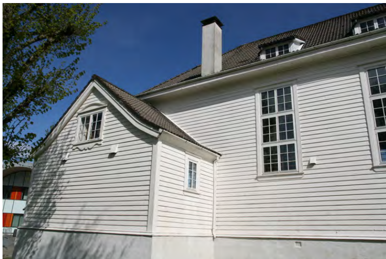
Fasade vest. Gjennomført detaljering. Opphavsrett: Statsbygg.
