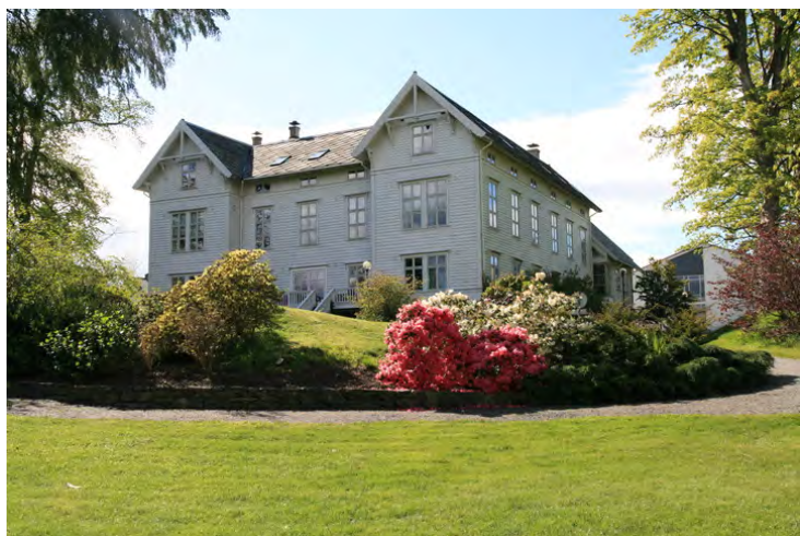
Pent opparbeidet uteområde rundt hovedbygningen. Opphavsrett: Statsbygg.
