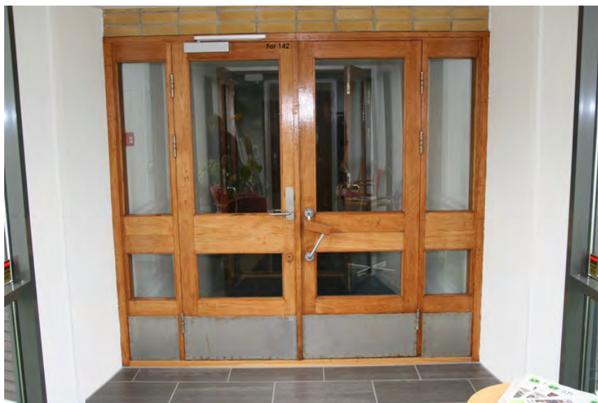
Inngangsdør typisk for tidsperioden. Opphavsrett: Statsbygg.
