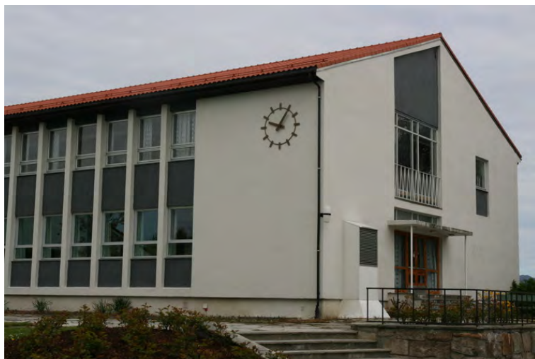
Karakteristisk 1960-talls skolearkitektur. Opphavsrett: Statsbygg.
