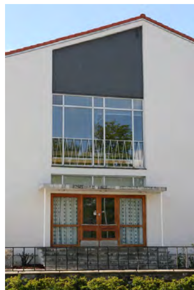
Vindusfeltene, rekkverk og dørpartiet er viktige for det lette og tidstypiske arkitektoniske uttrykket. Opphavsrett: Statsbygg.
