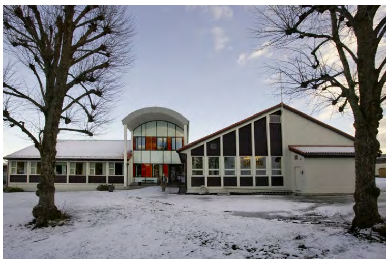
Nytt mellombygg mellom musikk- og formingsavdeling. Opphavsrett: Statsbygg.
