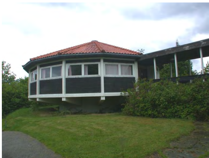
Fasade vest. Gangforbindelsen til høyre er senere endret. Opphavsrett: Statsbygg.
