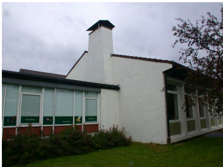
Pipa er tilknyttet en peis som har fått beholde sin opprinnelige form. Opphavsrett: Statsbygg.
