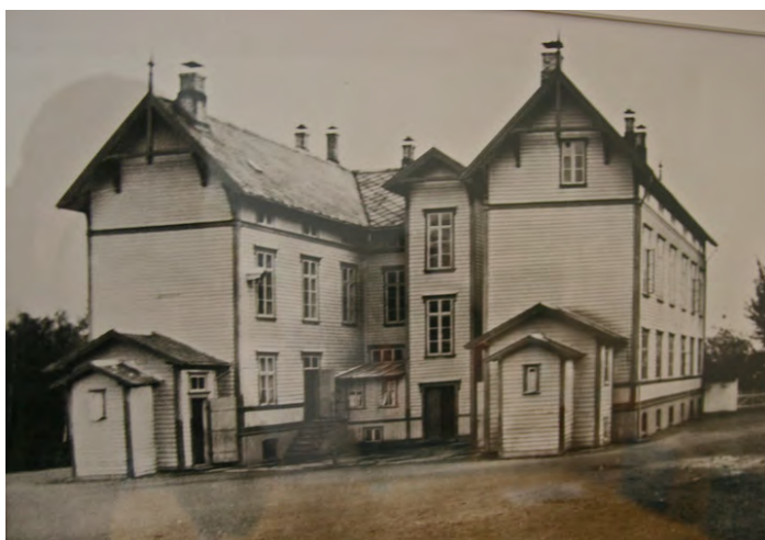
Opprinnelig hovedform, noen mindre tilbygg. Opphavsrett: Avfotografert bilde i bygningen.
