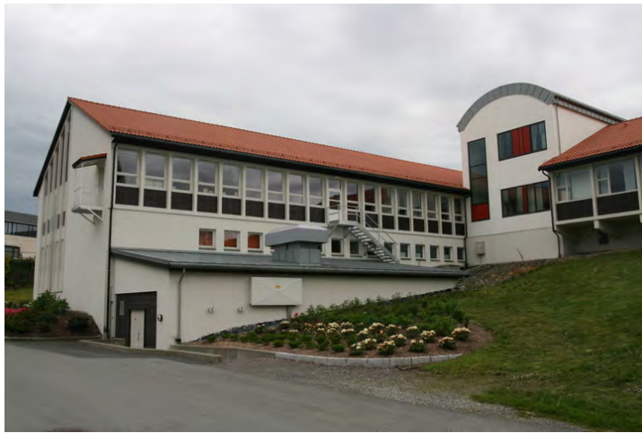
Nytt teknisk tilbygg og mellombygg. Musikkavdelingen t h. Opphavsrett: Statsbygg.
