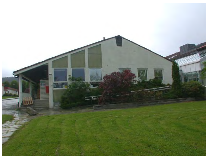
Eldre bilde, viser opprinnelig overbygd inngang til venstre. Opphavsrett: Statsbygg.
