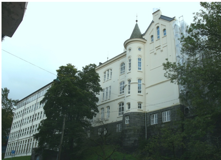
Hele fasaden mot Haugeveien. Opphavsrett: Statsbygg.
