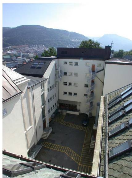
Fasader bakgård mot sørøst. Opphavsrett: Statsbygg.
