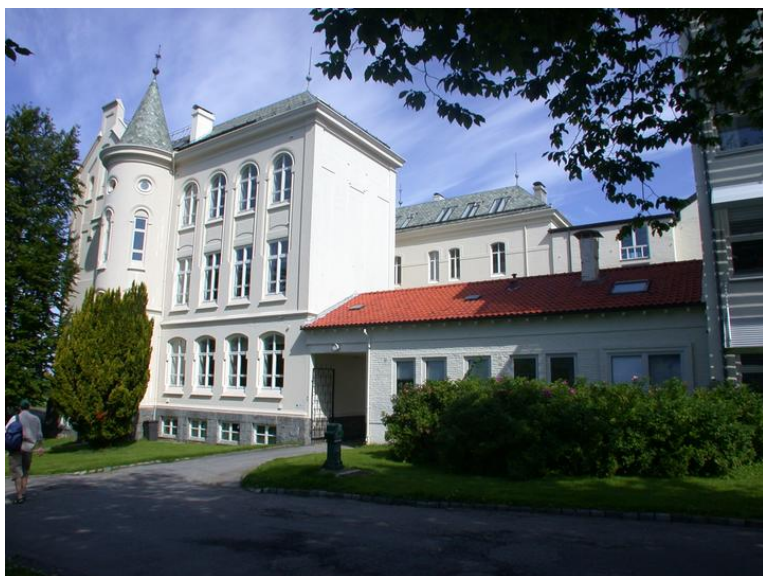
Fasade sørvest. Opphavsrett: Statsbygg.
