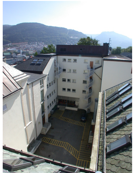
Tak på nybygg sett fra det gamle bygget. Opphavsrett: Statsbygg.
