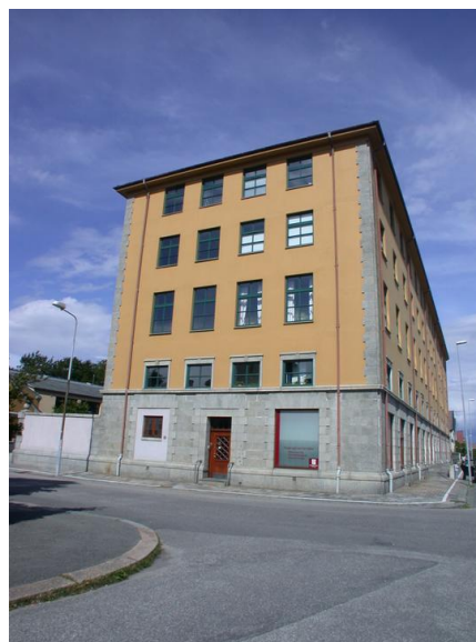
Fasade sørvest Foto: Ann- Kristin Strømmen Opphavsrett: Statsbygg
