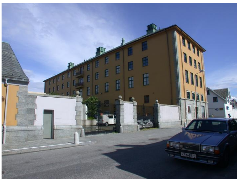
Fasade nordvest Foto: Ann- Kristin Strømmen Opphavsrett: Statsbygg
