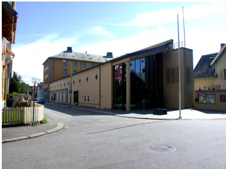
Hovedinngang Nybygg Foto: Ann- Kristin Strømmen Opphavsrett: Statsbygg
