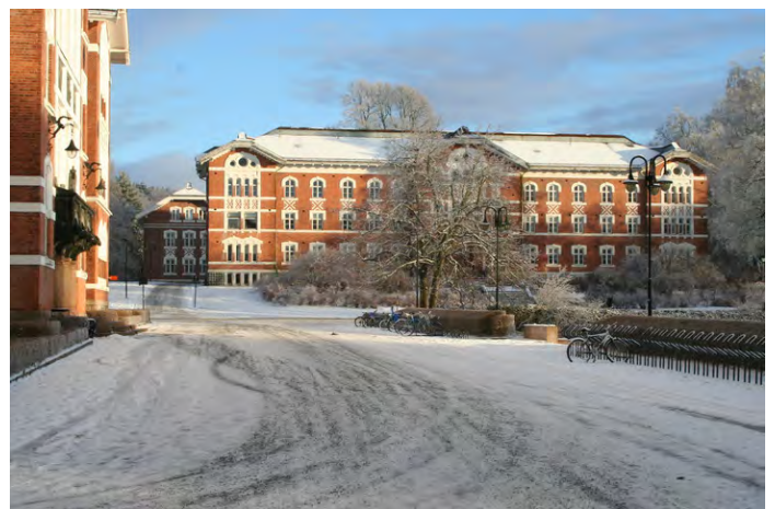
Cirkus, med del av Urbygningen til venstre, parken mot høyre. Opphavsrett: UMB.
