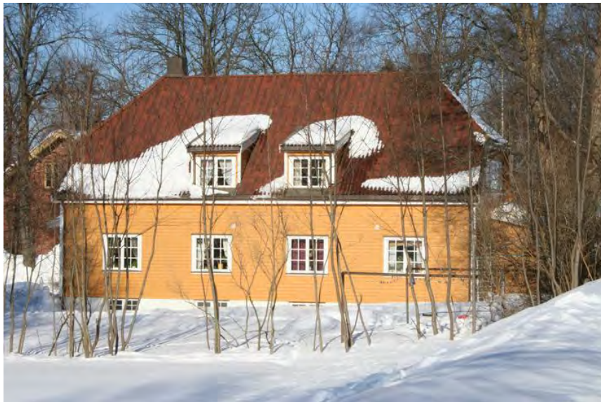
Stallmesterboligen sett fra sørøst. Foto: J.Chr. Eldal, 2006. Opphavsrett: NIKU.
