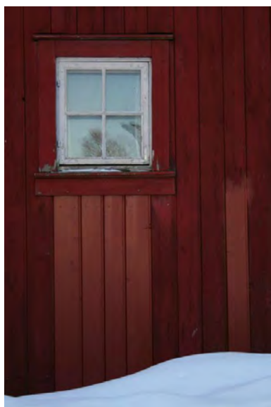
Ved reparasjon av panelet på nordøstveggen er bare enkelte bord skiftet ut. Foto: J.Chr. Eldal, 2006. Opphavsrett: NIKU.
