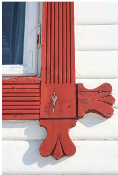
På de søndre fasadene er vinduer og gerikter delvis skiftet ut. Foto: J.Chr. Eldal, 2006. Opphavsrett: NIKU.
