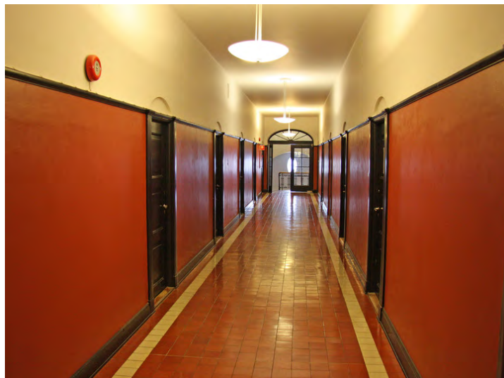
Korridor sett mot trapperom. Disse er like i 1.- 5. etasje. Opphavsrett: Statsbygg
