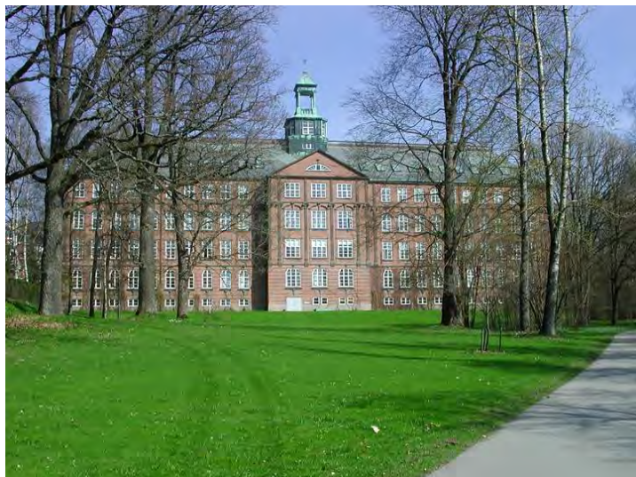
Tårnbygningens vestfasade. Foto: Bjørn Anders Fredriksen, UMB.
