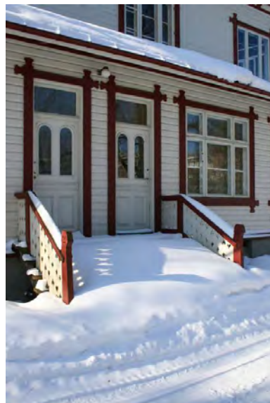
Damsgård sett fra øst. Kjøkkeninnganger med trapp fornyet i oppr. formspråk. Foto: J.Chr. Eldal, 2006. Opphavsrett: NIKU.
