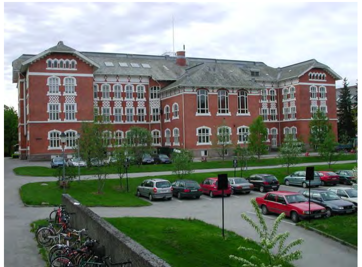
Urbygningens nordfasade. Foto: Bjørn Anders Fredriksen, UMB.
