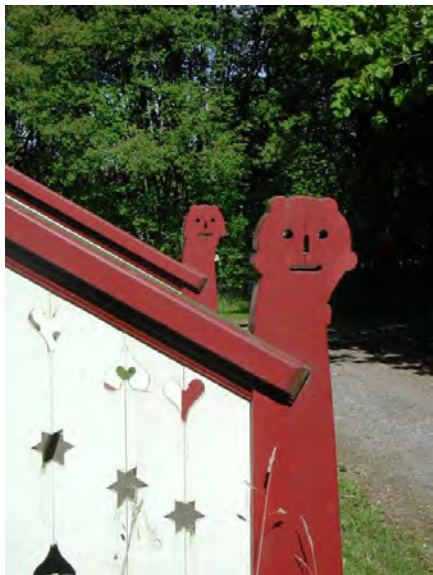
Damsgård, detalj av rekkverk fornyet ca. 1995. Foto: Bjørn Anders Fredriksen. Opphavsrett: UMB.
