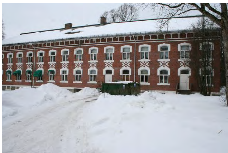
Økonomibygningens sørfasade. Foto: J.Chr. Eldal, 2006. Opphavsrett: NIKU.
