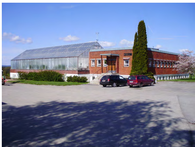
Botanisk klimalaboratorium. Opphavsrett: Statsbygg.
