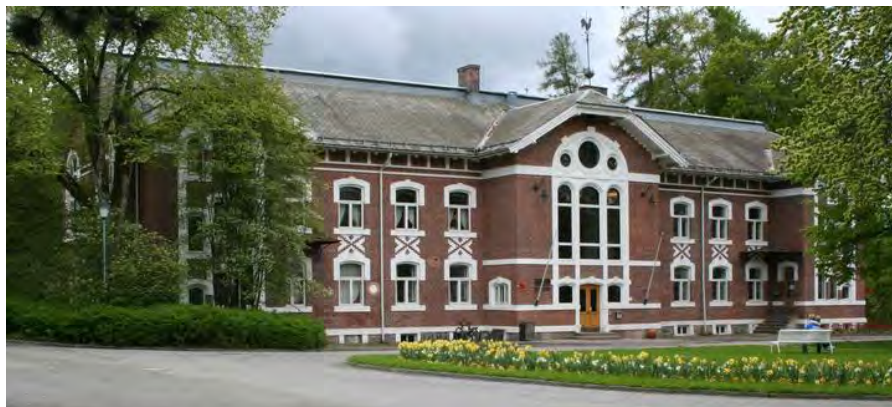
Økonomibygningens nordfasade mot tunet. Foto: J.Chr. Eldal, 2006. Opphavsrett: NIKU.
