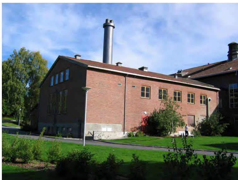
Varmesentralen Foto: Bjørn Anders Fredriksen
