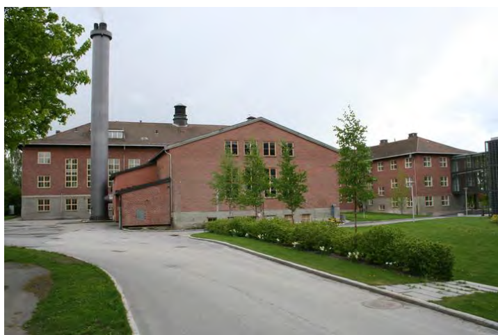
Meieriinstituttet sett fra nord med varmesentralen i forgrunnen og forbindelsesgangen til Bioteknologibygget t.h. Foto: J.Chr. Eldal, 2006. Opphavsrett: NIKU.
