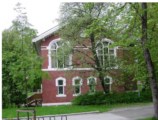
Økonomibygningens østfasade. Sisesalens store vinduer i 2. etg. Foto: Bjørn Anders Fredriksen. Opphavsrett: UMB.
