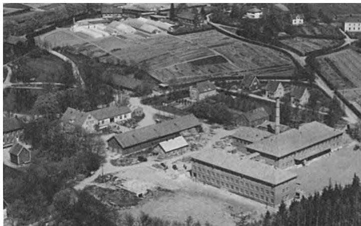
Flyfoto 1950-åra. Varmesentralen ses med høy pipe bak Meieribygningen. Opphavsrett: UMB.
