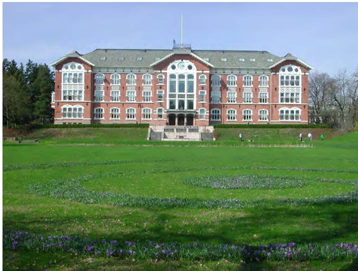
Urbygningens hovedfasade mot sør. Foto: Bjørn Anders Fredriksen.
