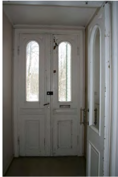
Østre vindfang sett mot nord. Foto: J.Chr. Eldal, 2006. Opphavsrett: NIKU.
