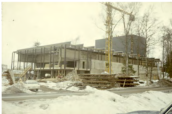
NLH, bygging av Aud Max. Foto: Anton Hjeltne NLH. Opphavsrett: UMB.
