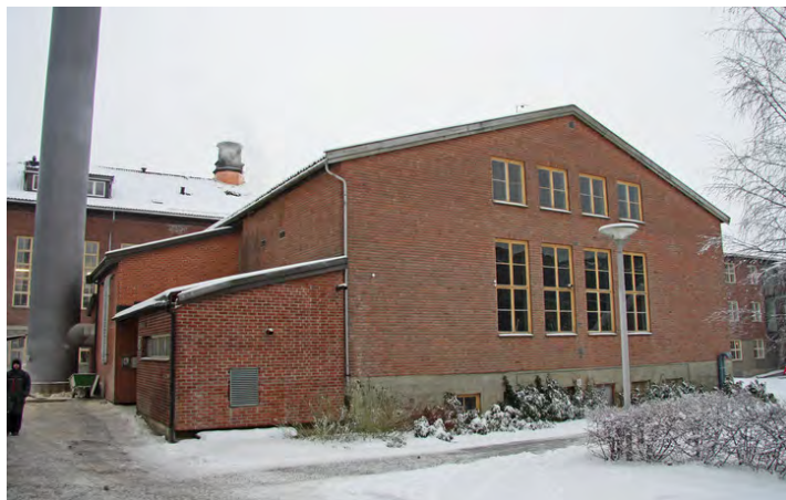
Nyere tilbygg til venstre. Opphavsrett: Statsbygg.
