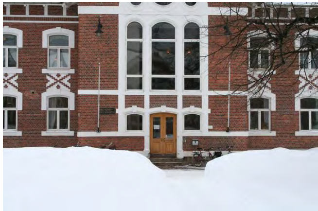
Økonomibygningens hovedinngang. Foto: J.Chr. Eldal, 2006. Opphavsrett: NIKU.
