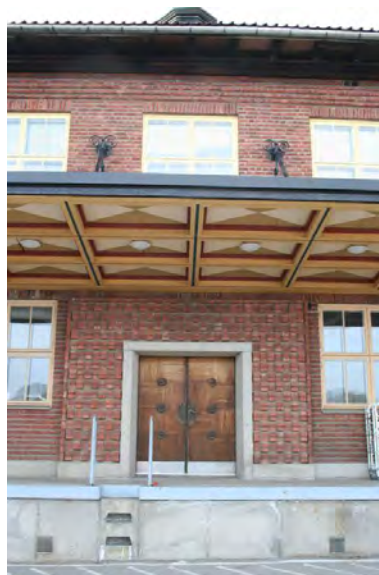
Meieriinstituttets østfløy med rampe og portal. Foto: J.Chr. Eldal, 2006. Opphavsrett: NIKU.
