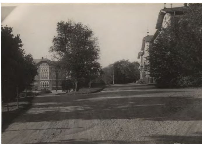
Adkomstveien mot Urbygningen og forplass til Cirkus ca. 1925. Foto: O. L. Moen. Opphavsrett: UMB.
