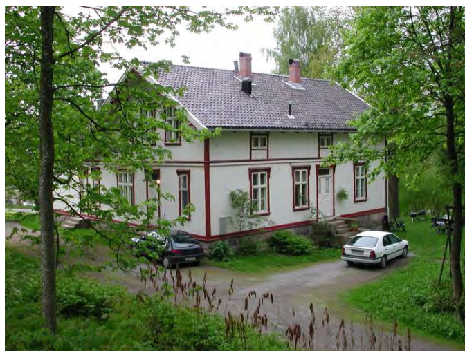
Vest- og nordfasader sett fra alleen i Åsbakken. Foto: Bjørn Anders Fredriksen. Opphavsrett: UMB.
