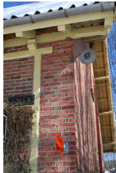
Søndre hjørne 2006. Spor i bindingsverk og mur viser at deler av bindingsverket er fjernet og sørøstre gavlvegg ommurt. Foto: J.Chr. Eldal, 2006. Opphavsrett: NIKU.
