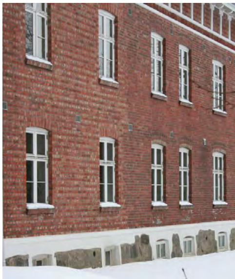
I Tivolis nordfasade ses skillet mellom Holtermanns del t.h. og Sverres forlengelse t.v. Foto: J.Chr. Eldal, 2006. Opphavsrett: NIKU.
