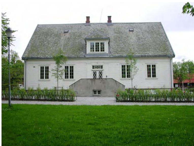
Posthusgården, sydfasade. Foto: Bjørn Anders Fredriksen. Opphavsrett: UMB.
