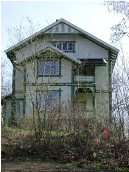
Fougnerbakken 18-20, fasade mot nord. Foto: Bjørn Anders Fredriksen. Opphavsrett: UMB.
