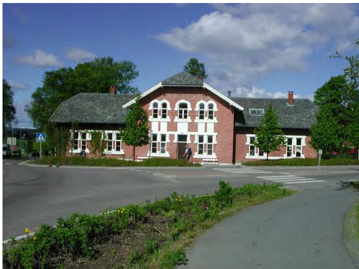
Meierimuseet sett fra øst. Foto: Bjørn Anders Fredriksen. Opphavsrett: UMB.
