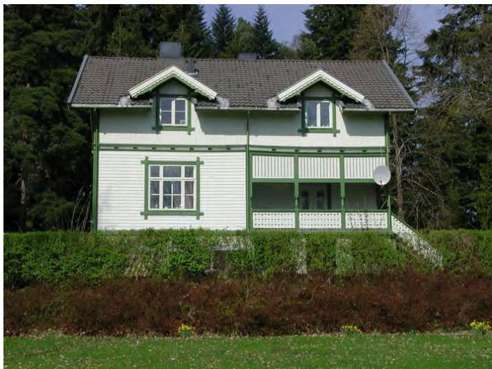
Sørfasade. Hagetrappen er flyttet fra opprinnelig plass i verandaens midtakse, og verandafronten har mistet buknær i sidefeltene og høy bueåpning i midten. Opphavsrett: UMB.
