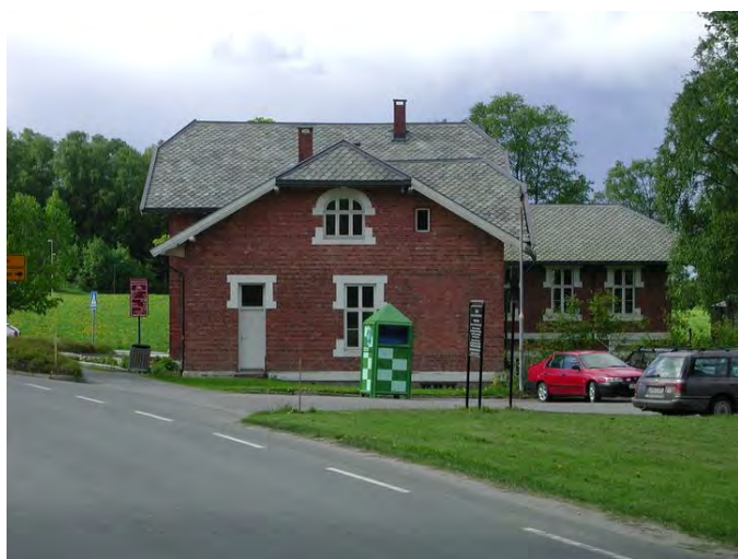
Meierimuseet sett fra nord. Foto: Bjørn Anders Fredriksen. Opphavsrett: UMB.
