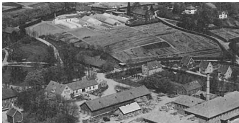
Flyfoto fra 1950-åra. Stallmesterboligen omtrent midt i bildet. Opphavsrett: UMB.
