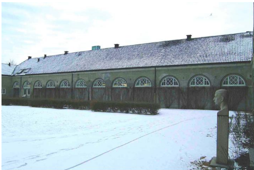
Fasade mot parken. Opphavsrett: Statsbygg
