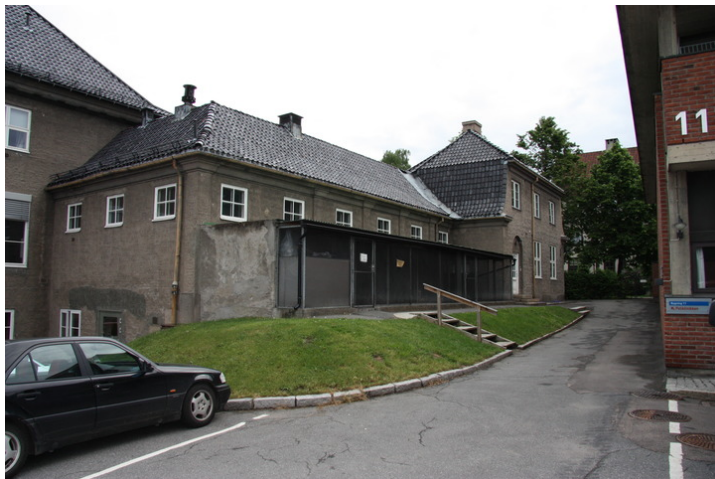
Sørfasade til sørøst-fløy. Opphavsrett: Statsbygg
