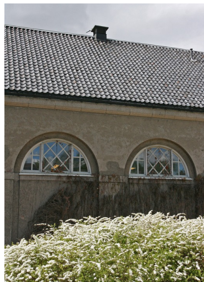
Østfasade. Opphavsrett: Statsbygg
