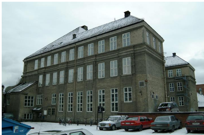
Fasade mot øst. Opphavsrett: Statsbygg.
