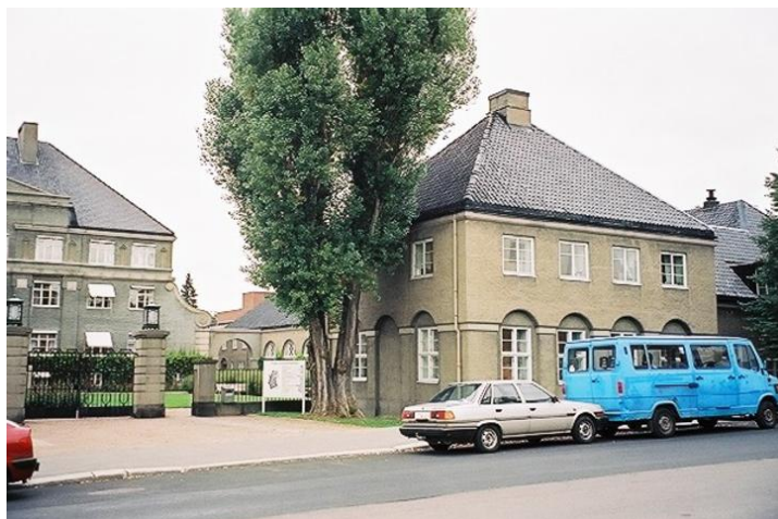
Fasade mot General Birchs gate og den gamle hovedporten. Opphavsrett: Statsbygg.
