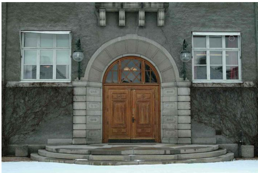
Den gamle hovedinngangen mot parken Opphavsrett: Statsbygg
