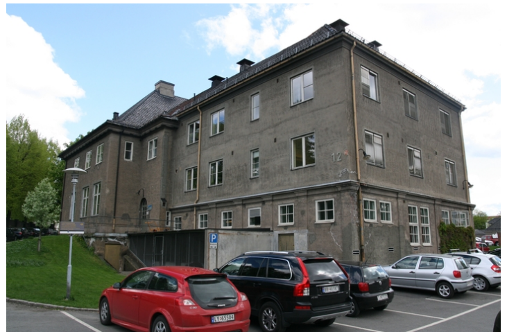
Fasade mot nord og vest. Opphavsrett: Statsbygg
