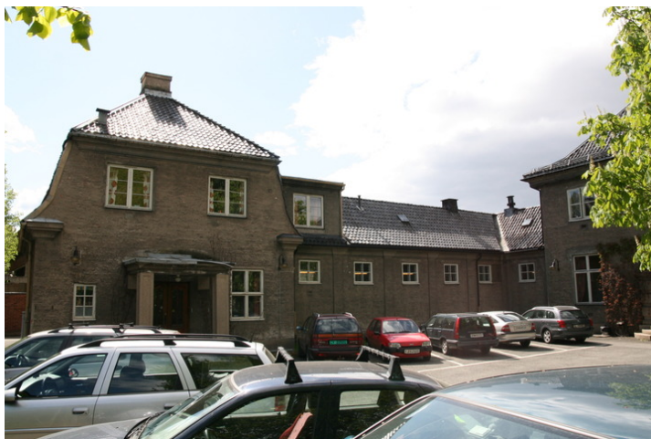
Sørøst-fløy. Hovedinngang i høyre billedkant. Opphavsrett: Statsbygg
