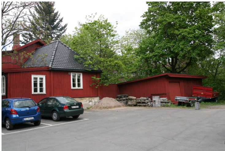
Fra vest. Opphavsrett: Statsbygg.
