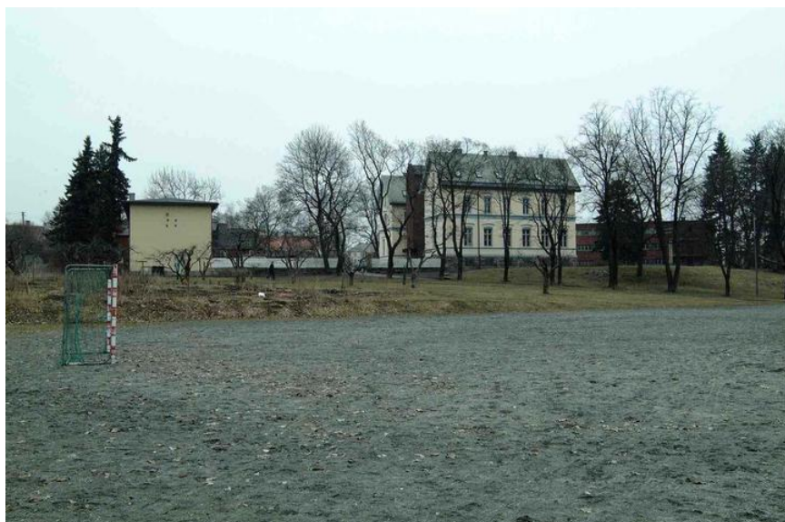
Anlegget sett fra nord, fra Thulstrups gate. Opphavsrett: Statsbygg.
