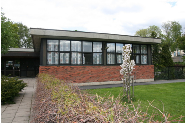
Østfløy med trimrom mm. Opphavsrett: Statsbygg.
