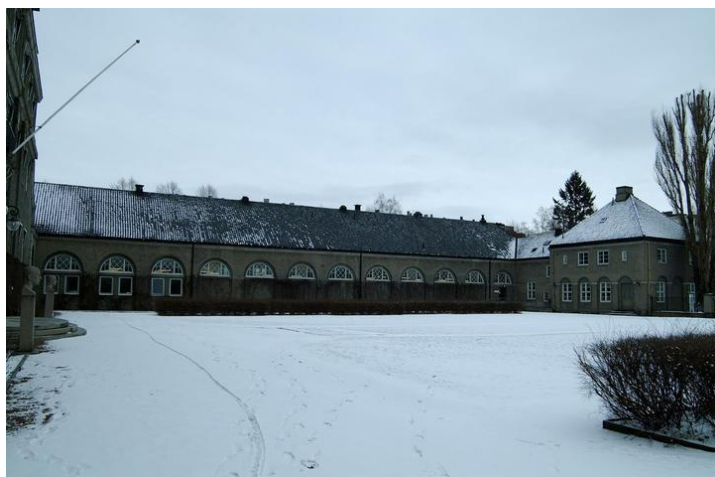
Fasade mot parken. Opphavsrett: Statsbygg
