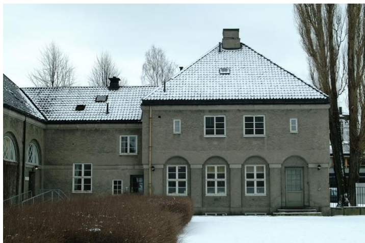
Sydfløyens fasade mot parken. Opphavsrett: Statsbygg.
