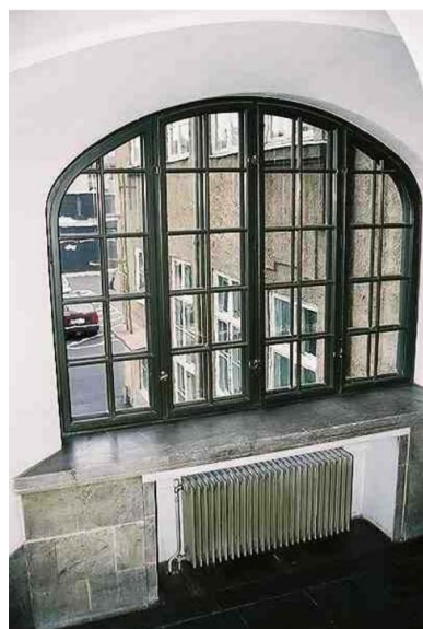
Eksempel på vindu i hovedtrapperom. Opphavsrett: Statsbygg.
