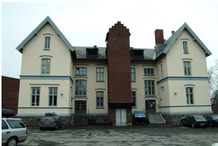
Fasade mot øst. Opphavsrett: Statsbygg.
