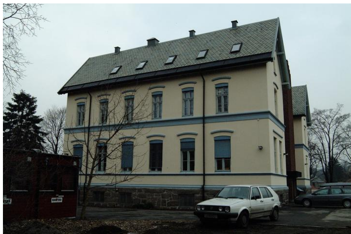
Fasade mot syd. Opphavsrett: Statsbygg.
