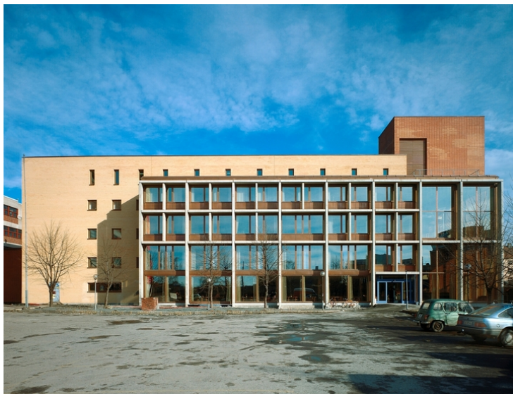
Fasade mot sørvest. Hovedinngang og torg/plass foran bygningen. Opphavsrett: Statsbygg.
