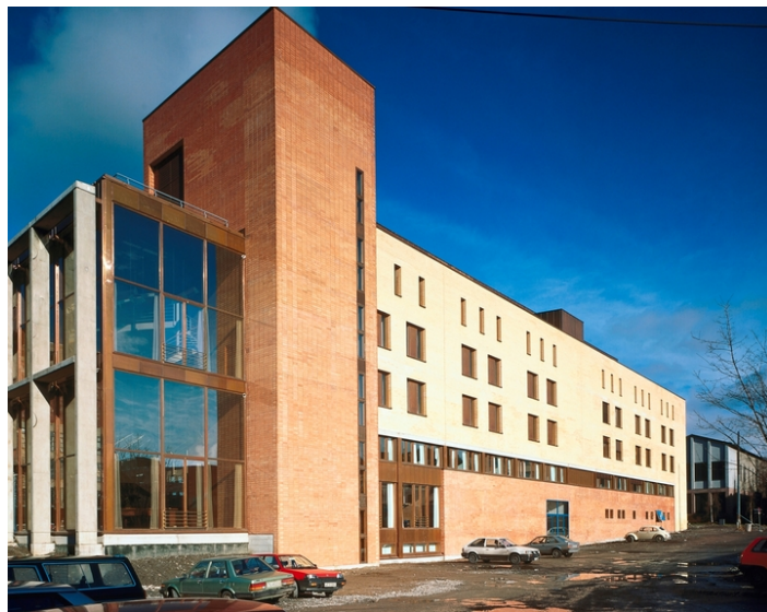
Fasade mot sørøst. Frontbygget t.v. med utenpåliggende raster og store glassflater samt tårnoppbygget omfattes av vernet. Opphavsrett: Statsbygg.
