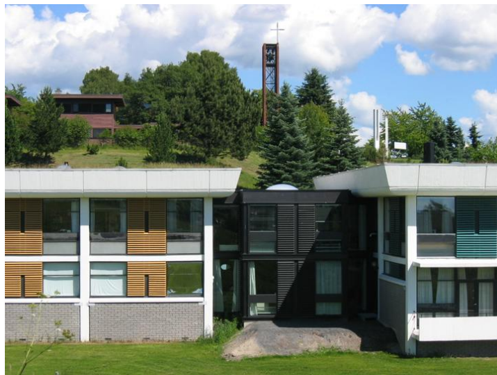
Mellombygg mellom Gulstua og Grønnstua. Vestfasader. Opphavsrett: Statsbygg.
