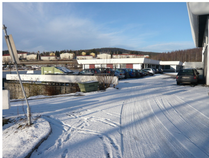
Rødstua sett fra sør. Opphavsrett: Statsbygg.
