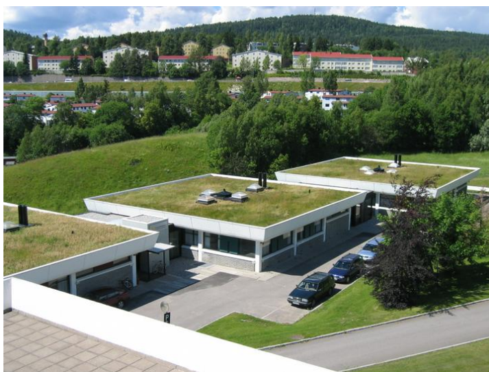
Taket på Grønnstua mellom Rødstua og Gulstua. Opphavsrett: Statsbygg.
