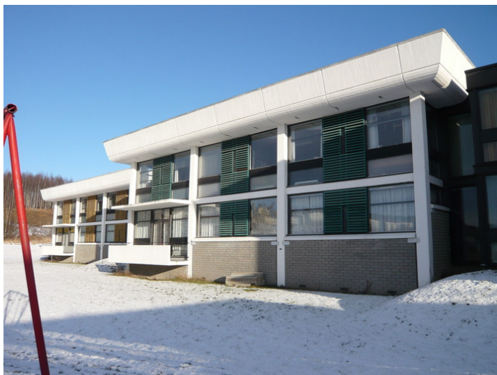
Grønnstua sett fra vest, Gulstua i bakgrunn. Opphavsrett: Statsbygg.
