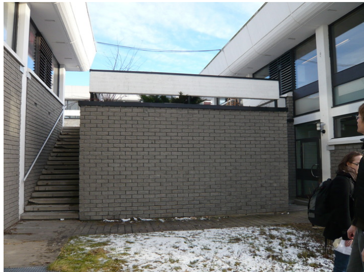
Trapp mellom Brunstua og Blåstua. Opphavsrett: Statsbygg.
