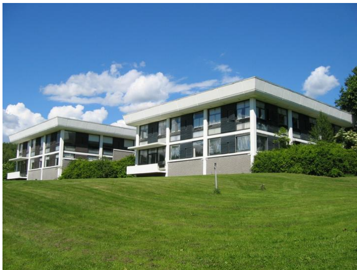
Fra sør. I bakgrunnen synes Brunstua. Opphavsrett: Statsbygg.
