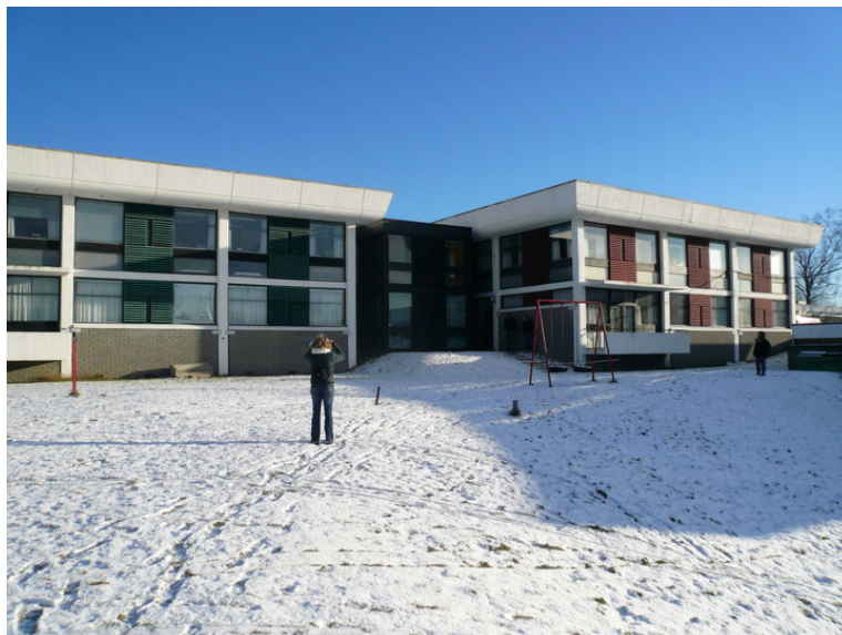
Fasade sett fra vest med nytt mellombygg. Opphavsrett: Statsbygg.
