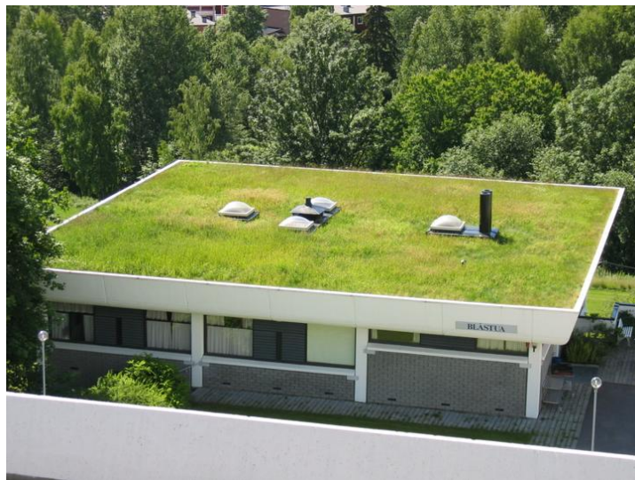
Taket. Foto tatt fra taket på hovedbygget. Opphavsrett: Statsbygg.
