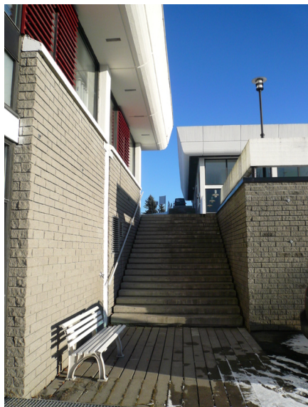
Trapp ned fra Hovedbygning og parkering langs fasade syd. Opphavsrett: Statsbygg.
