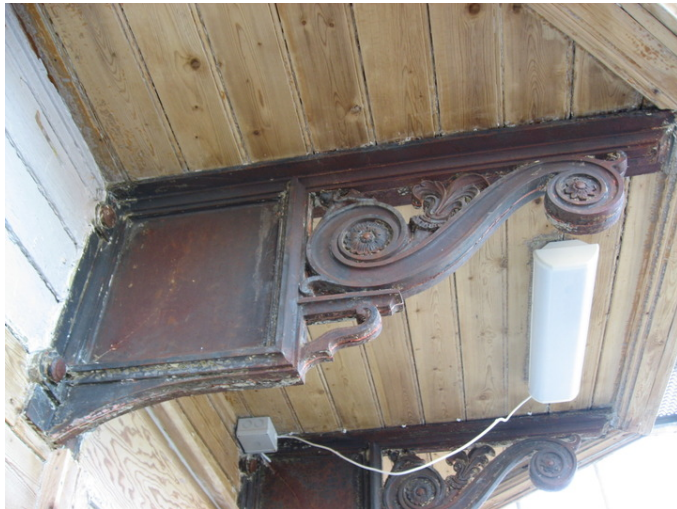
Detalj inngangsparti mot sjøen. Opphavsrett: UiO.
