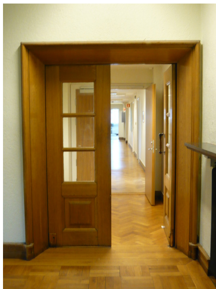
Korridor nne etasje med eikedører mot vestibylen og malte furudører i selve korridoren. Opphavsrett: Statsbygg.
