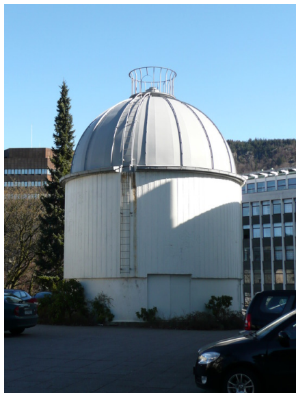
Betatronen sett fra vest. Opphavsrett: Statsbygg.
