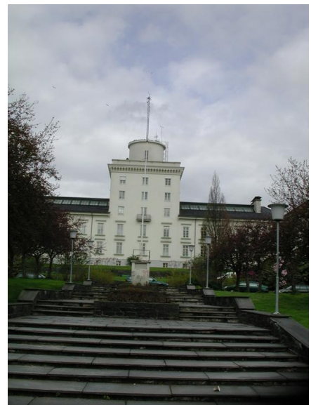
Allégaten 70 sett fra trappeanlegg i sørøst. Opphavsrett: Statsbygg.
