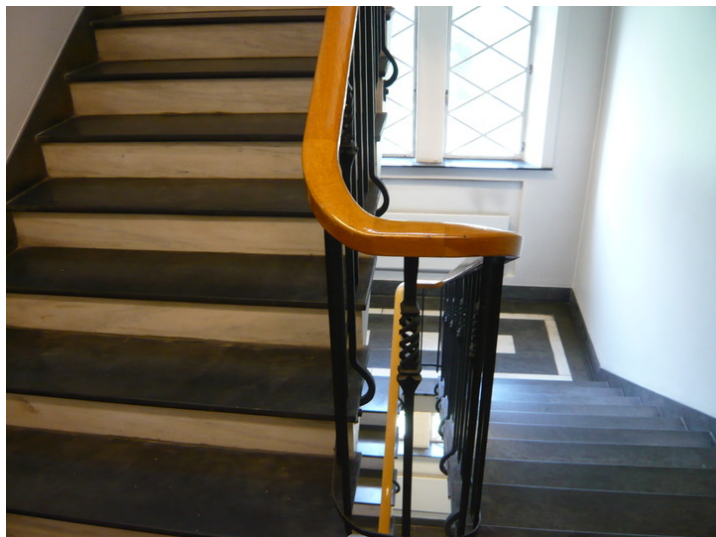
Hovedtrapp med skifer og marmor Opphavsrett: Statsbygg.
