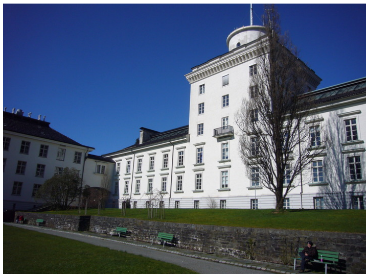
Geofysen med vestfløy/Botanisk laboratorium m/ mellombygg. Opphavsrett: Statsbygg.
