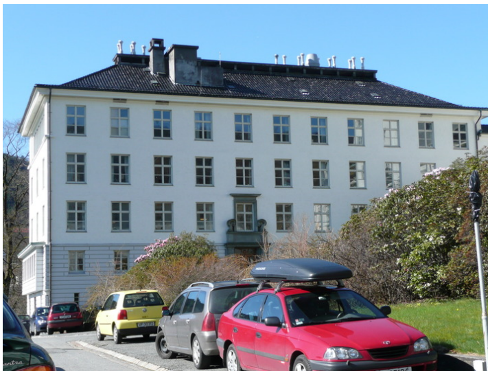
Fasade mot øst. Opphavsrett: Statsbygg.
