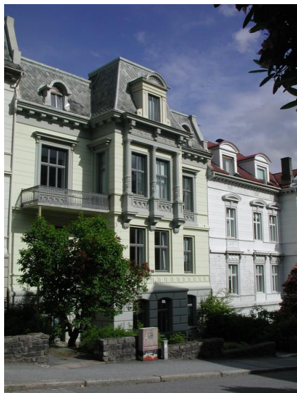
Christies gate 15, fasade mot sør (midt i bildet). Foto: Jostein Nyseth. Opphavsrett: UiB.
