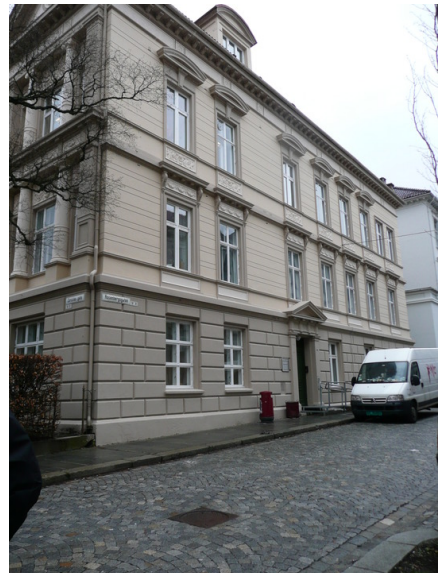
Ørjan Øyens hus. Opphavsrett: Statsbygg.
