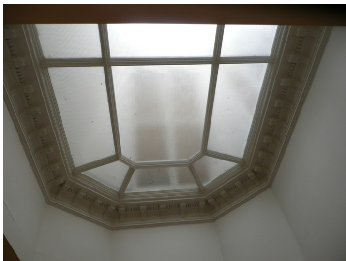
Overlys over trappeoppgang. Opphavsrett: Statsbygg.
