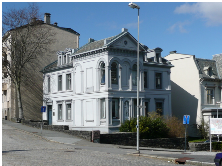
Christiesgt. 19. Opphavsrett: Statsbygg.
