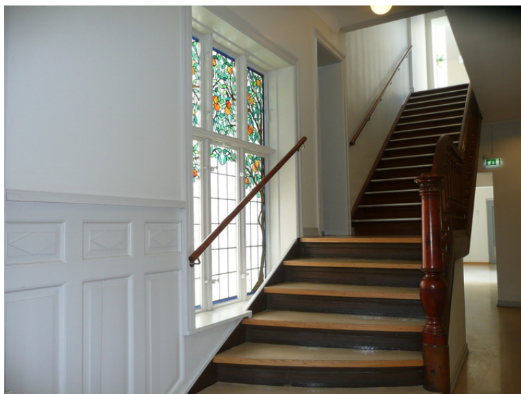
Opprinnelig hovedtrapp, brystningspaneler. Opphavsrett: Statsbygg.
