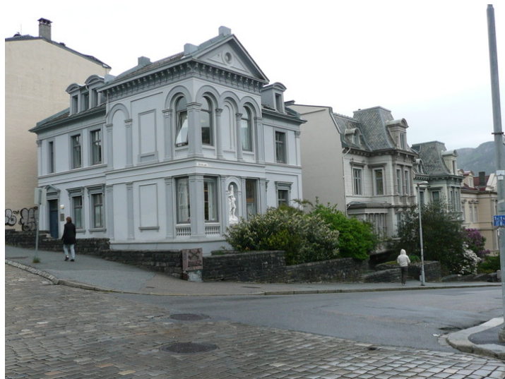
Fasade mot syd og vest. Opphavsrett: Statsbygg.
