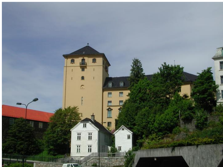
Fasade mot sør. Foto: Jostein Nyseth. Opphavsrett: UiB.
