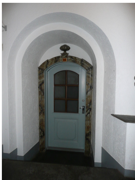
Dør Interiør. Opphavsrett: Statsbygg.
