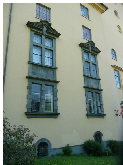
Utsnitt fasade m/ vinduer. Opphavsrett: Statsbygg.
