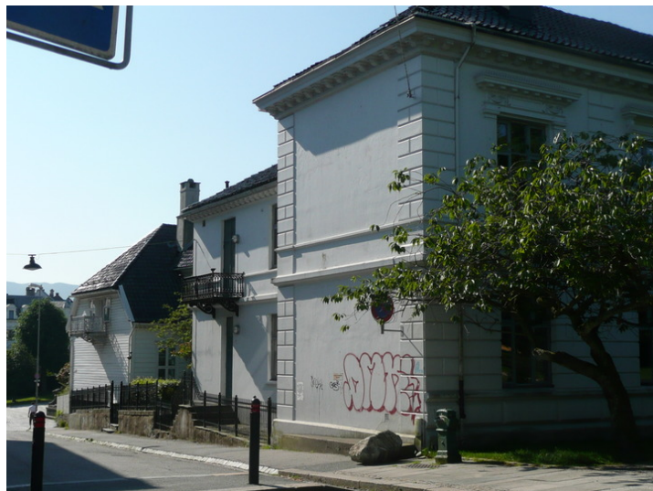
Fasade mot øst, Langesgt. 3 helt til venstre i bildet. Opphavsrett: Statsbygg.
