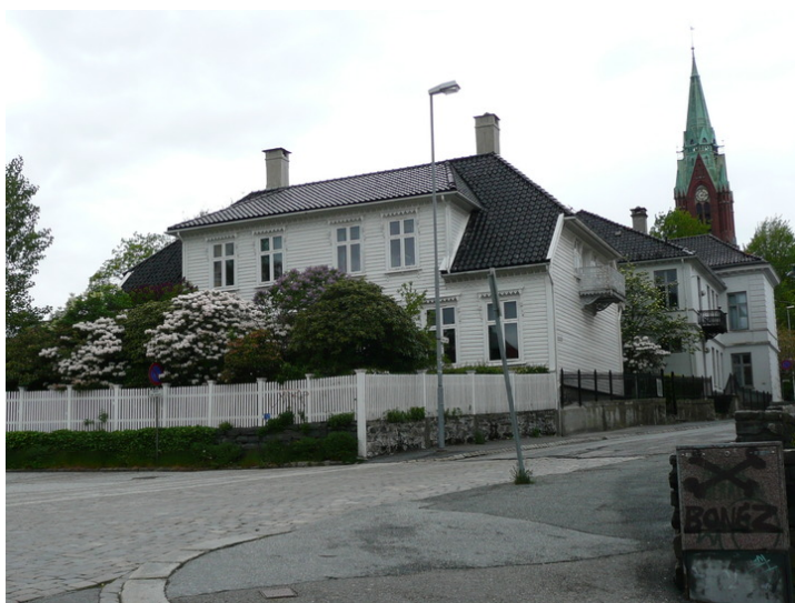
Fasade mot syd. Opphavsrett: Statsbygg.
