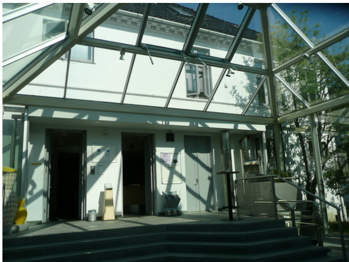
Fasade syd mot nytt glassbygg. Opphavsrett: Statsbygg.
