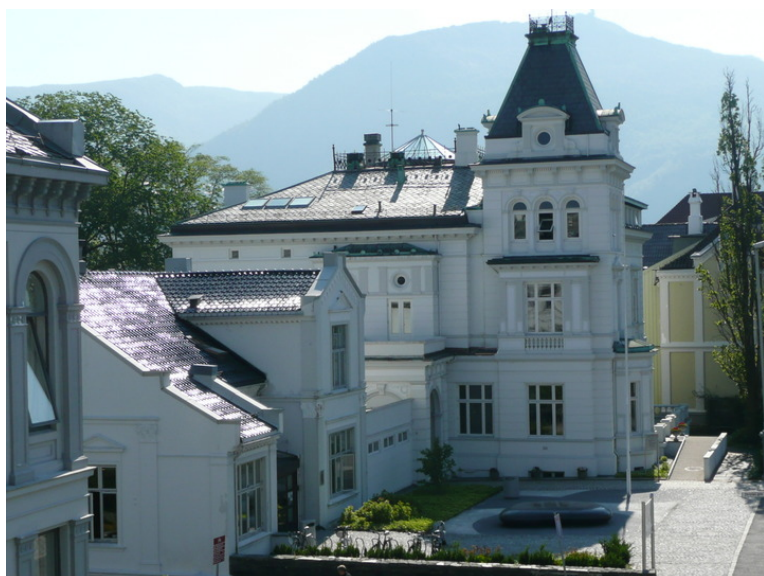
Fasade mot sydvest, med Christiesgate 20 til venstre. Opphavsrett: Statsbygg.
