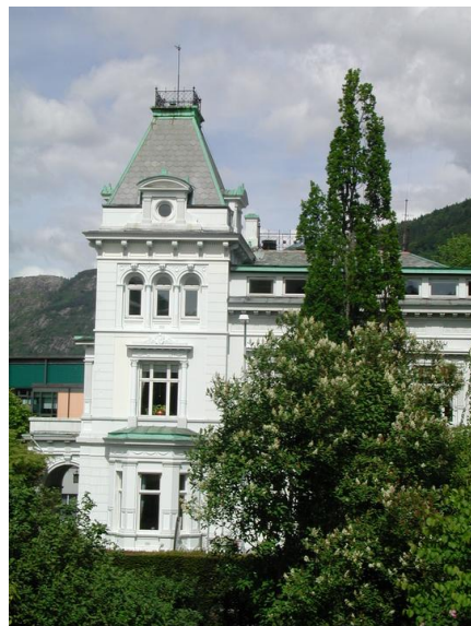
Utsnitt av fasade m/ tårn mot sydvest. Opphavsrett: Statsbygg.
