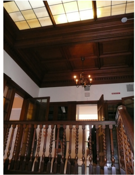
Tak over trapp i 2 etasje. Opphavsrett: Statsbygg.
