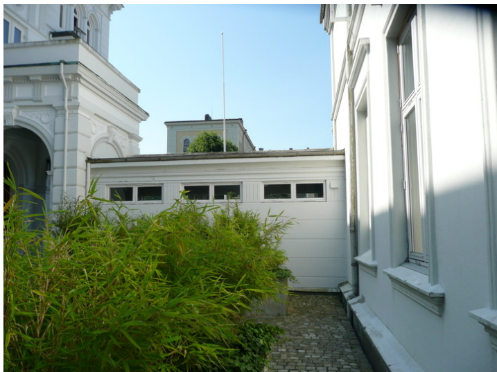
Mellomgang mellom Christies gate 20 og Museplass 1 sett fra nordøst. Opphavsrett: Statsbygg.
