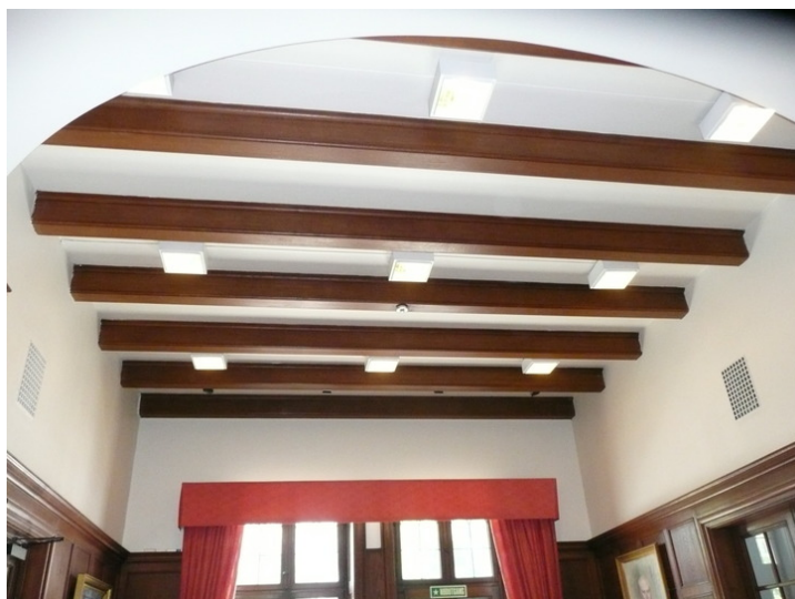
Tak over inngangshall 1 etasje. Opphavsrett: Statsbygg.
