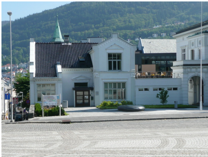
Fasade mot sydvest. Christies gate 20. Opphavsrett: Statsbygg.
