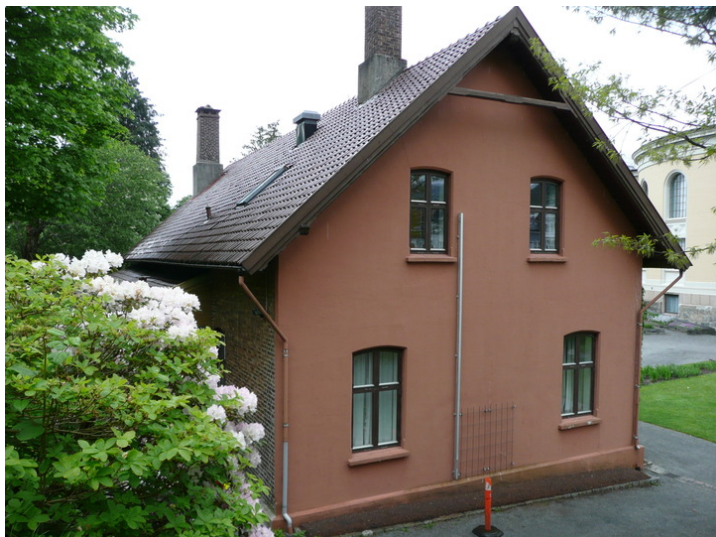
Gartneribygning. Opphavsrett: Statsbygg.
