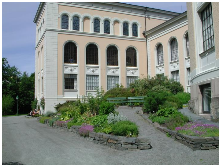
Fasade mot vest, mot museumshagen. Opphavsrett: Statsbygg.
