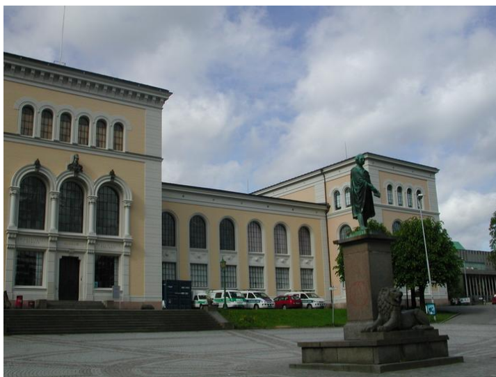
Østfasade, sett fra Muséplassen. Opphavsrett: UiB.
