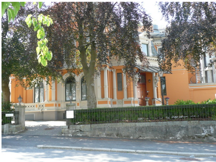
Inngangspartiet mot Parkvn. Opphavsrett: Statsbygg.
