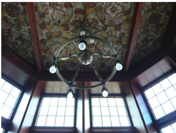
Tak i karnapp i trapperom. Opphavsrett: Statsbygg.
