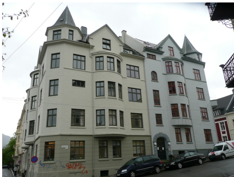
Fasade nordvest mot Dokkeveien, Øisteinsgate 1 til venstre. Opphavsrett: Statsbygg.
