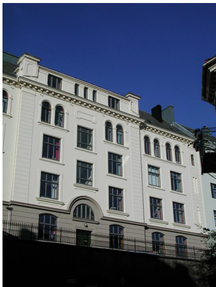
Øisteinsgate 3, fasade mot nordøst. Opphavsrett: Statsbygg.
