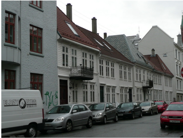
Sydneshaugen 10 midt i rekken og med høyere tak/loft kledd med skifer. Opphavsrett: Statsbygg.
