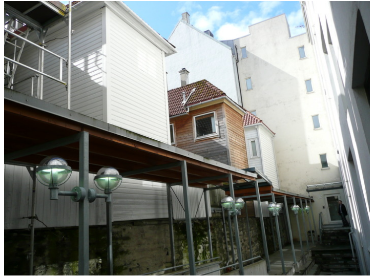
Sydneshaugen 10, fasade mot gårdsrom, den første hvite bygningsskroppen. Opphavsrett: Statsbygg.
