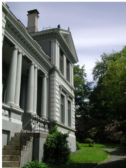
Villaveien 9, fasade mot sydvest. Opphavsrett: UiB.
