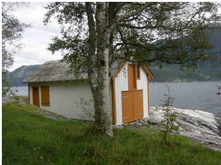
Naust. Sydvest fasade. Opphavsrett: UiB.
