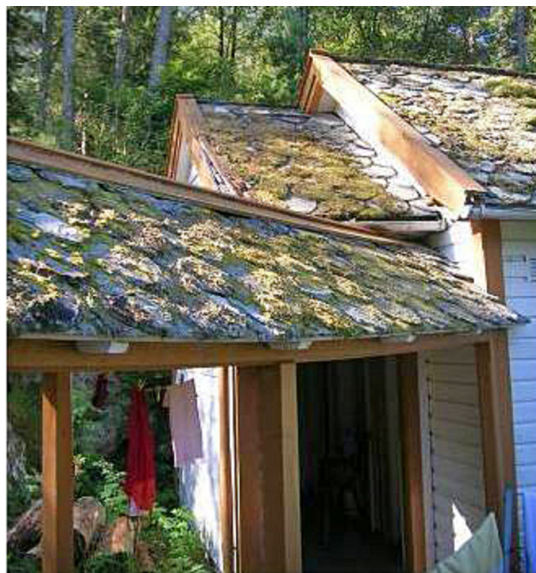
Anneks før restaurering. Opphavsrett: UiB.
