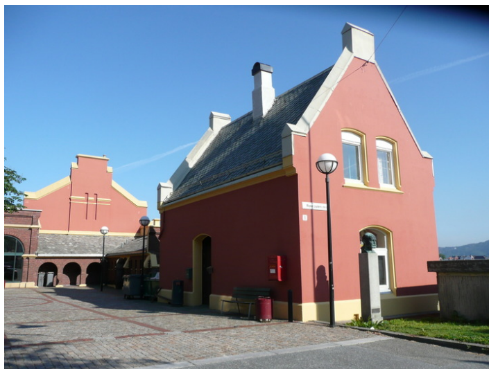
Gymnastikksal og vaktmesterbolig sett fra sydøst. Opphavsrett: Statsbygg.
