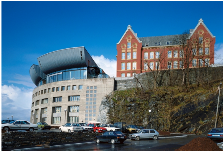
Jusbygget/Dragefjellet skole. Fasader mot syd/vest, Foto: Jiri Havran. Opphavsrett: Jiri Havran.
