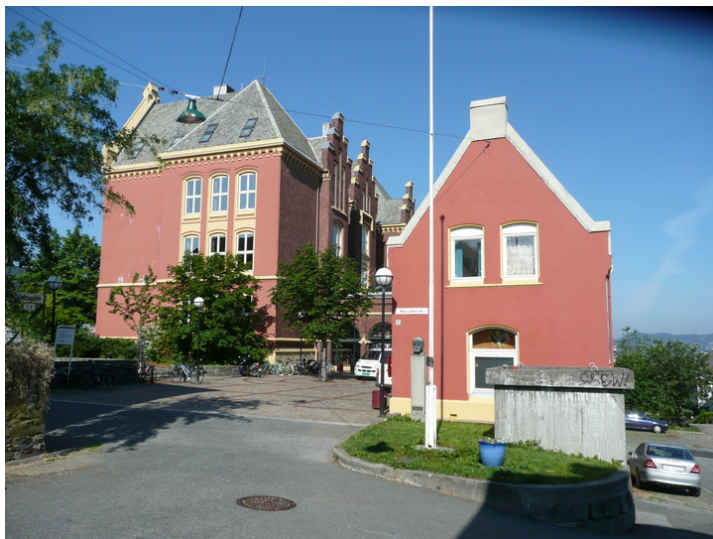
Fasade mot sydøst, Vaktmesterboligen til høyre. Opphavsrett: Statsbygg.
