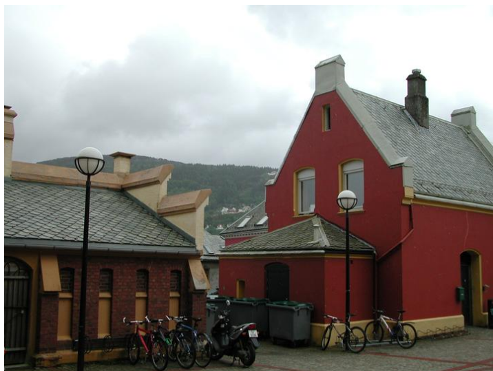
Fasade mot nordvest. Del av sykkelkur til venstre. Opphavsrett: Statsbygg.
