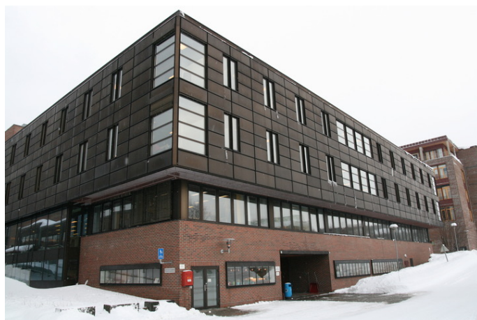
Nord-østfasaden til høyre. Opphavsrett: Statsbygg.
