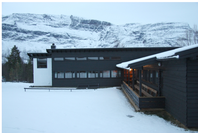
Spisesal og peisestue i fløy t.v. Opphavsrett: Statsbygg.
