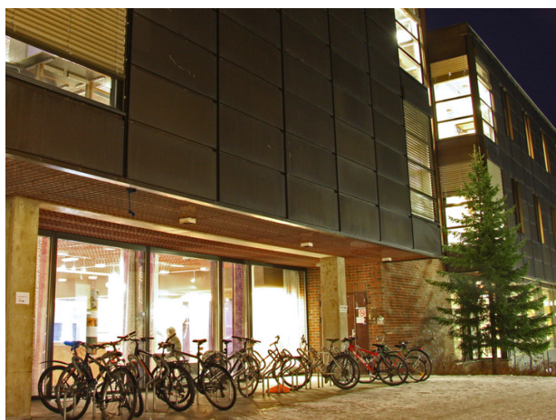
Kveldsstemming, sørøstfasade. Opphavsrett: Statsbygg.
