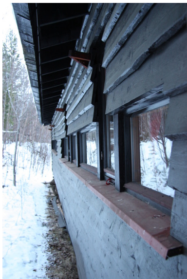
Fasadedetaljer. Hytte A. Opphavsrett: Statsbygg.
