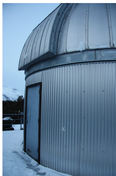
Inngang til kuppelen med luke for teleskop over. Opphavsrett: Statsbygg.
