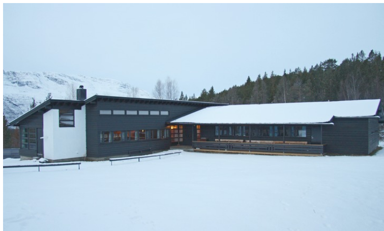
Hovedhus. Opphavsrett: Statsbygg.
