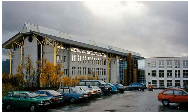
Bakfløyen har enklere detaljering i eksteriøret. Opphavsrett: Statsbygg.
