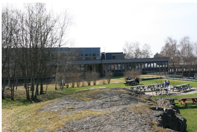
Forbindelsesgang mellom Sentralbygg og vestibyle. Opphavsrett: Statsbygg.
