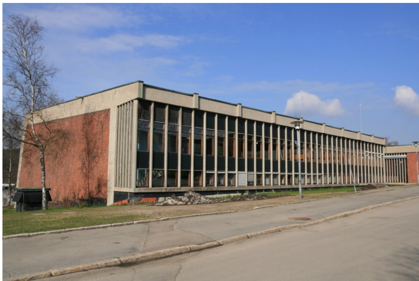
Fasade mot inngangen sett fra sydøst. Opphavsrett: Statsbygg.
