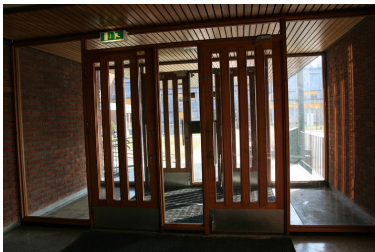
Inngangsparti med vindfang. Opphavsrett: Statsbygg.
