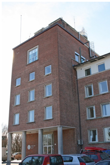
Tårnets fasade mot nord. Opphavsrett: Statsbygg.
