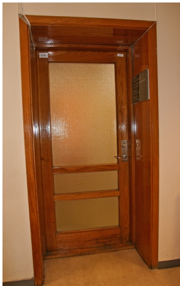
Opprinnelig dør mot resepsjonen. Opphavsrett: Statsbygg.
