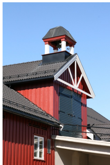
Klokketårn. Opphavsrett: Statsbygg.
