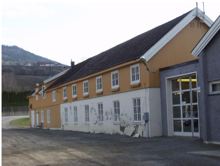
Nordre fasade. Opphavsrett: Statsbygg.
