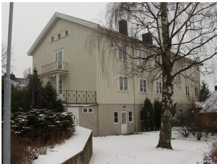
Internatets nordside mot parkeringsplassen. Opphavsrett: Statsbygg.
