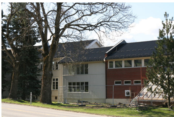
Fasade mot øst. Opphavsrett: Statsbygg.
