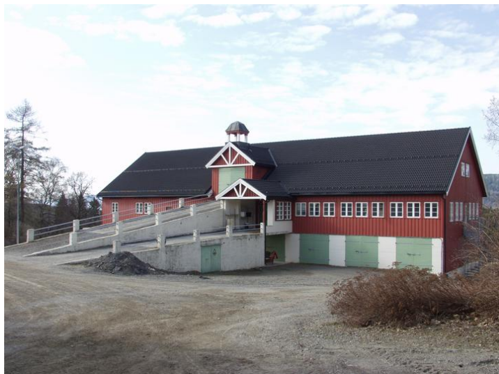
Fasade mot øst. Opphavsrett: Statsbygg
