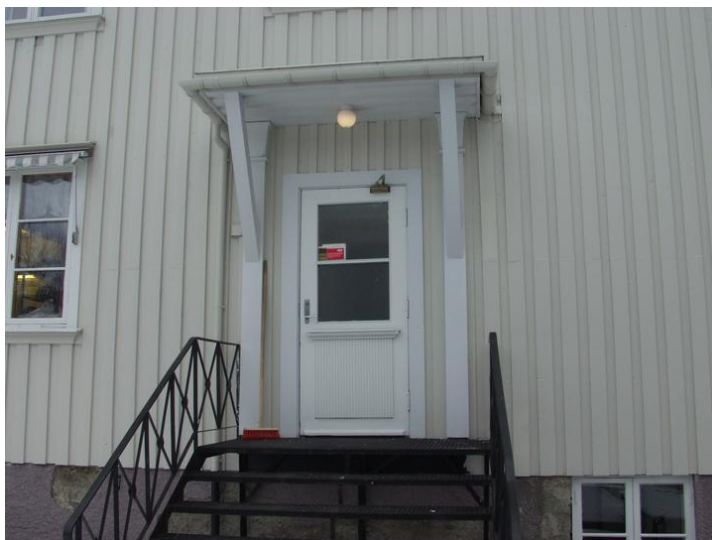
Detalj fra langvegg mot nord. Opphavsrett: Statsbygg.
