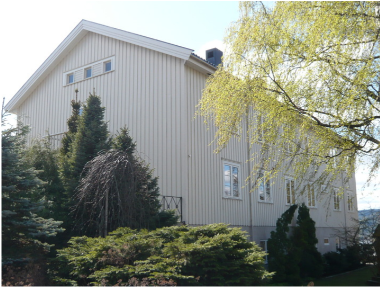
Gavlvegg mot nord og langvegg mot nord. Opphavsrett: Statsbygg.
