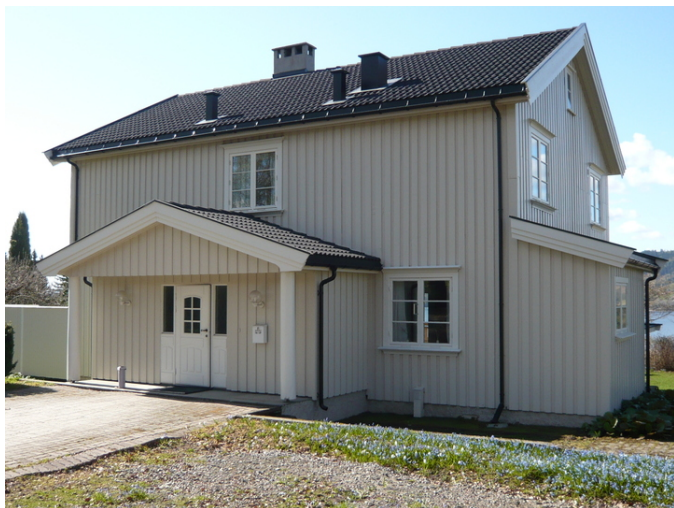
Inngangsfasade/fasade øst. Opphavsrett: Statsbygg.
