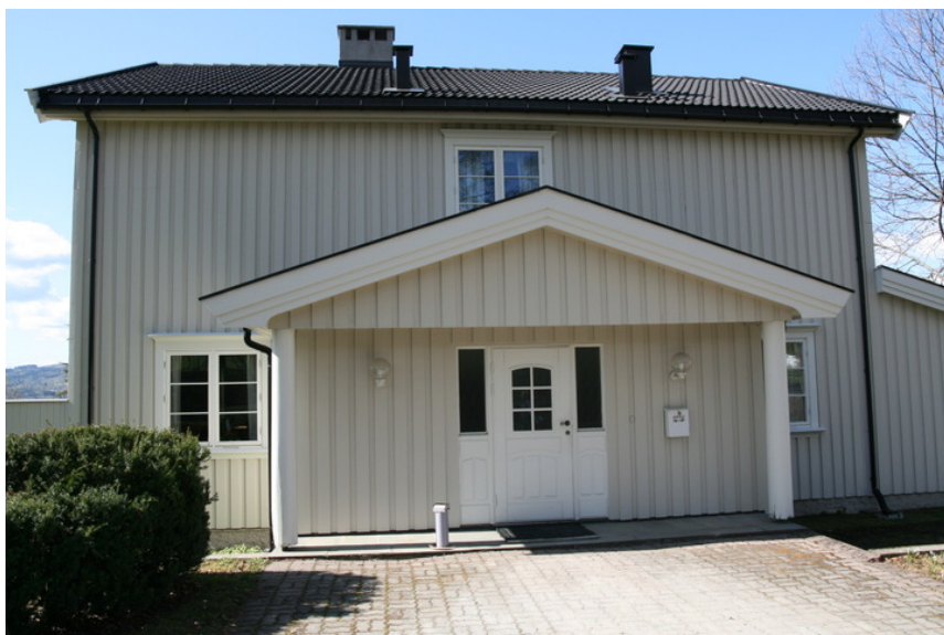
Inngangsparti. Opphavsrett: Statsbygg.
