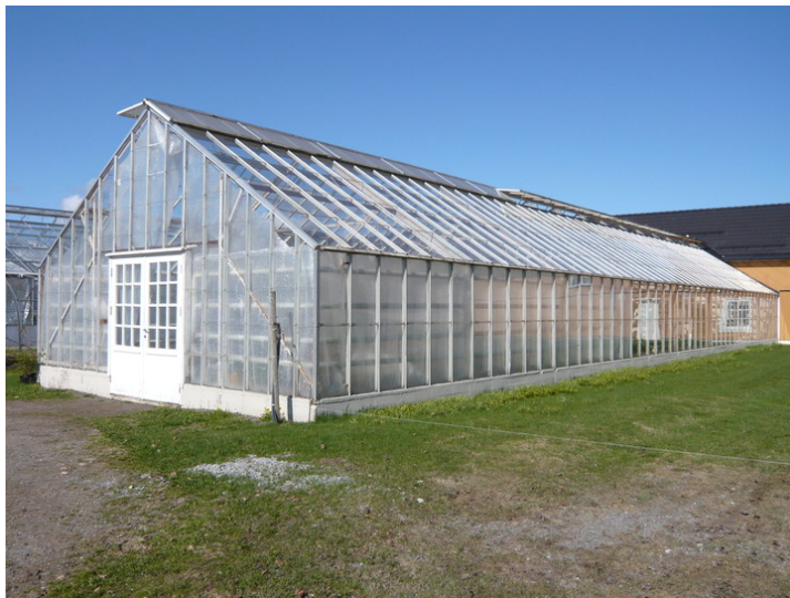
Gavl mot syd, fasade mot øst. Opphavsrett: Statsbygg.
