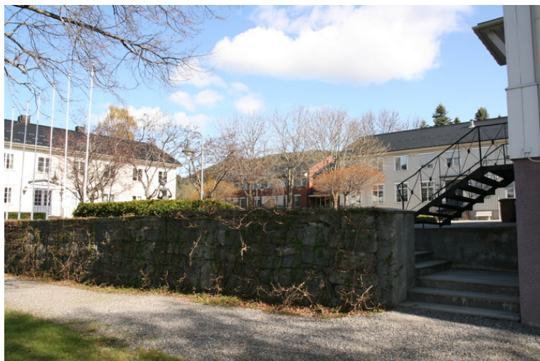
Inntunet. Opphavsrett: Statsbygg.
