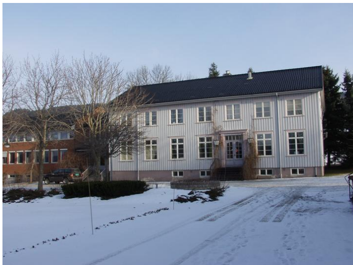
Administrasjonsbygg sett mot vest. Opphavsrett: Statsbygg.
