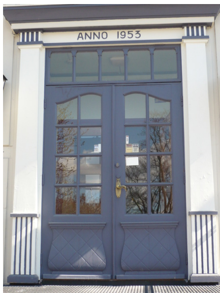
Hovedinngangsdør. Opphavsrett: Statsbygg.
