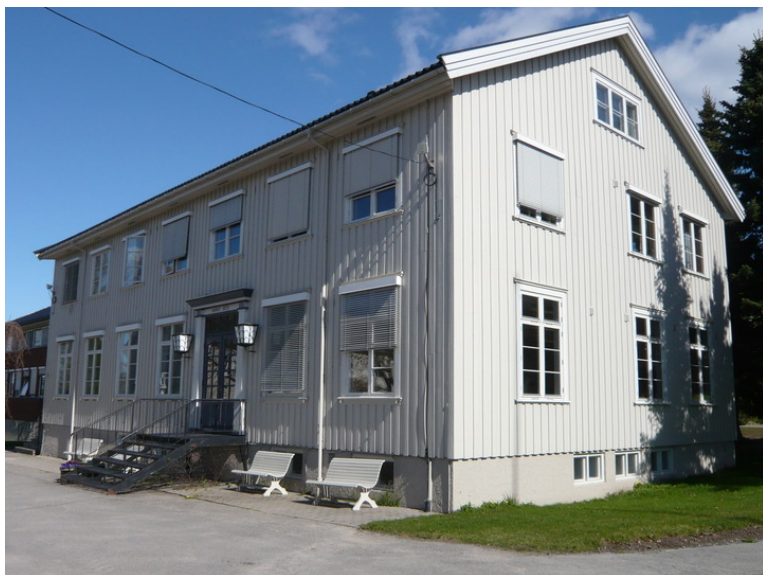
Fasade vest og syd. Opphavsrett: Statsbygg.
