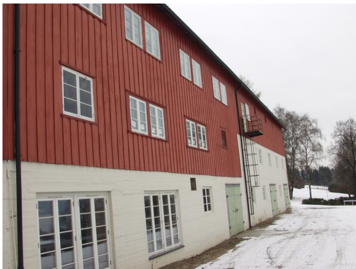
Langvegg mot vest. Opphavsrett: Statsbygg
