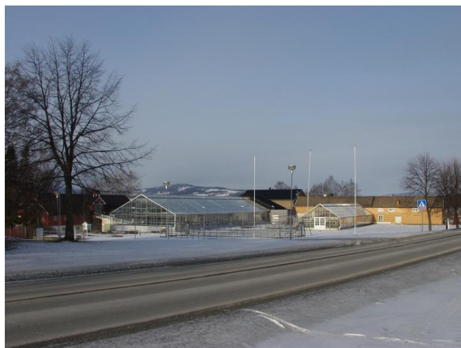
Driftsbygninger, veksthus og arbeidsrom. Opphavsrett: Statsbygg.
