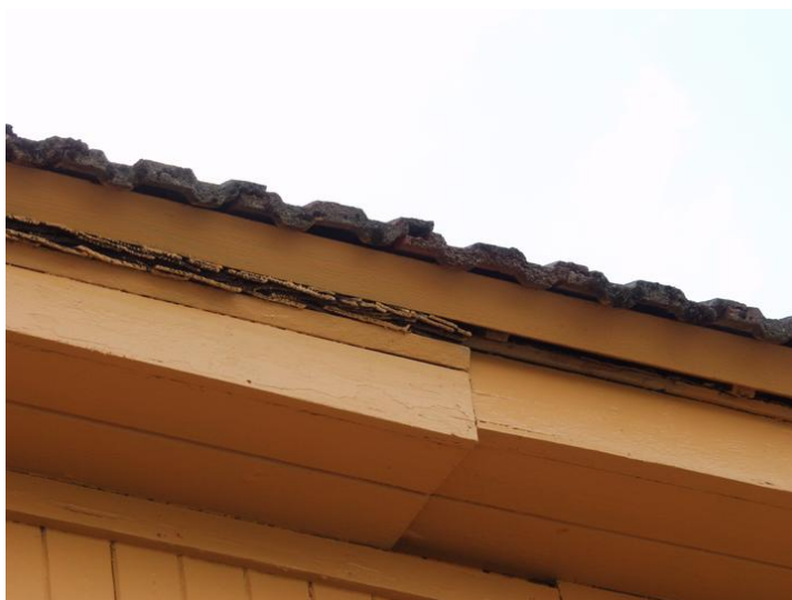
Bildet viser flistekking under sementstein Opphavsrett: Statsbygg.
