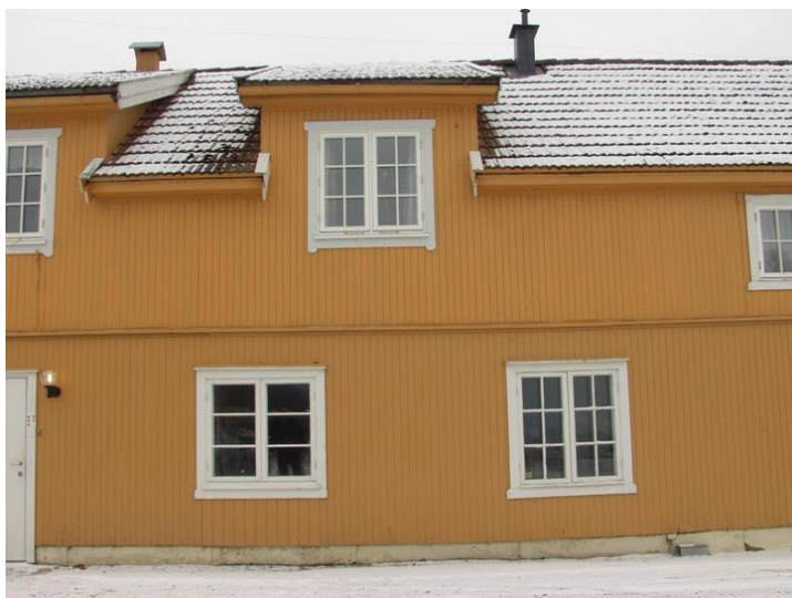
Nordre fasade har flere forskjellige typer vinduer. Opphavsrett: Statsbygg.
