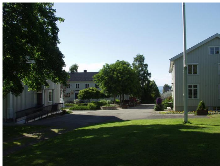
Vea søndre med kantina til venstre, internatet midt i bildet og administrasjonsbygningen til høyre. Opphavsrett: Statsbygg.
