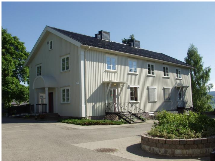
Kantinas nordfasade, mot tunet. Opphavsrett: Statsbygg.
