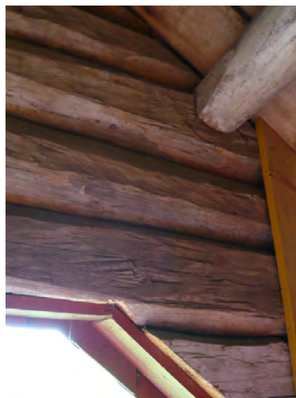
Tømmeret er i god stand. Opphavsrett: Statsbygg.
