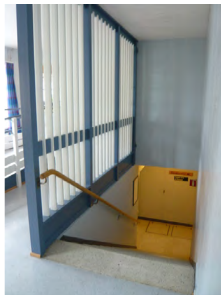
Trapp fra inngangspartiet ned i kjeller. Opphavsrett: Statsbygg.
