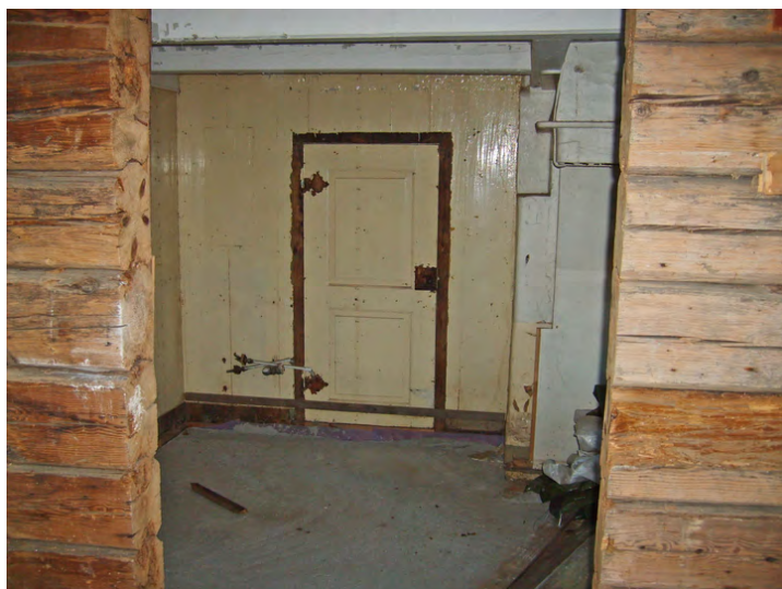
1 etg kjøkken. Opphavsrett: Statsbygg
