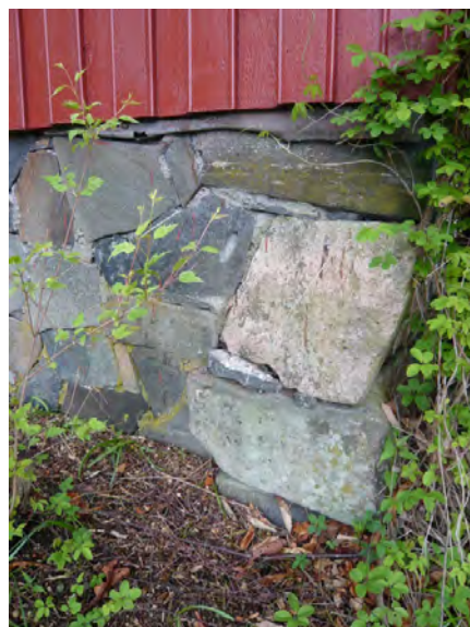
Grunnmur. Opphavsrett: Statsbygg.
