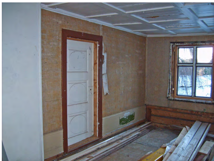
1 etg stue sør vest. Opphavsrett: Statsbygg.
