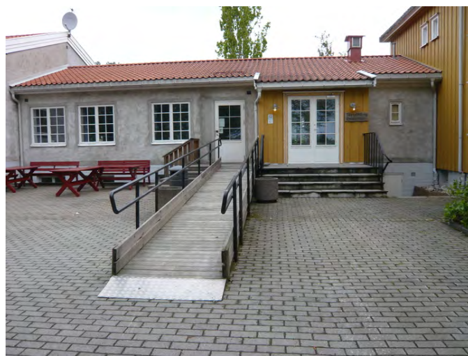
Fasade mot syd. Opphavsrett: Statsbygg.
