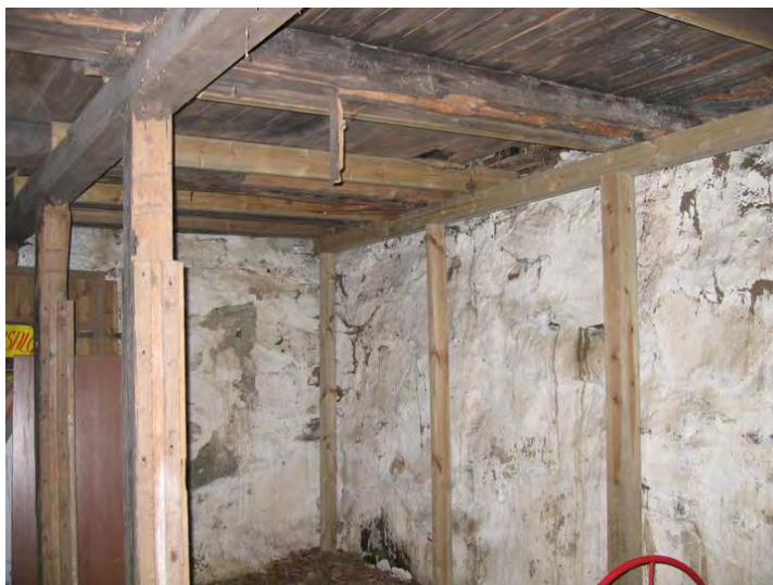
Potetkjellerens gulv er støttet opp med stendere. Opphavsrett: Statsbygg.
