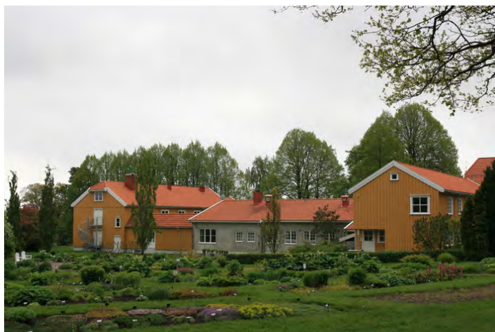
Fasade mot nord. I forgrunnen ligger i dag "Ibsens urtehage". Opphavsrett: Statsbygg.
