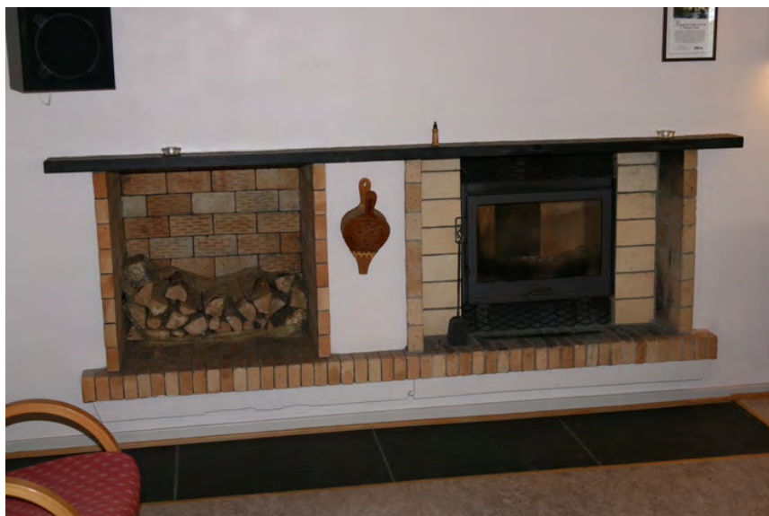
Peisen har fått en ny innsats, men er ellers intakt. Opphavsrett: Statsbygg.
