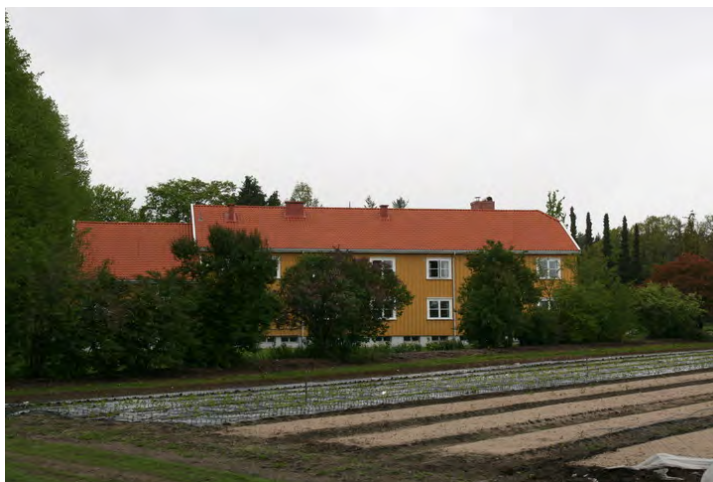
Fasade mot åker. Opphavsrett: Statsbygg.
