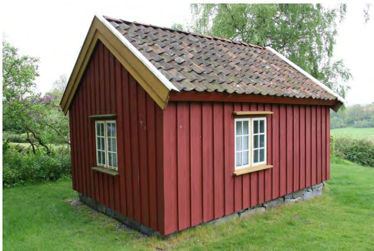
Fasder mot nord og øst. Opphavsrett: Statsbygg.
