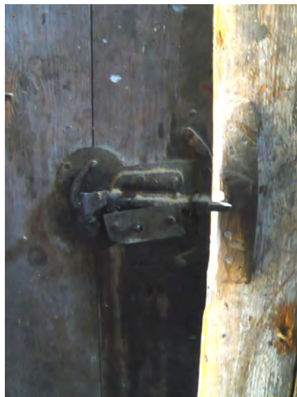
Dør til bryggerhus. Opphavsrett: Statsbygg.
