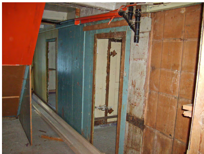
1 etg gang. Opphavsrett: Statsbygg
