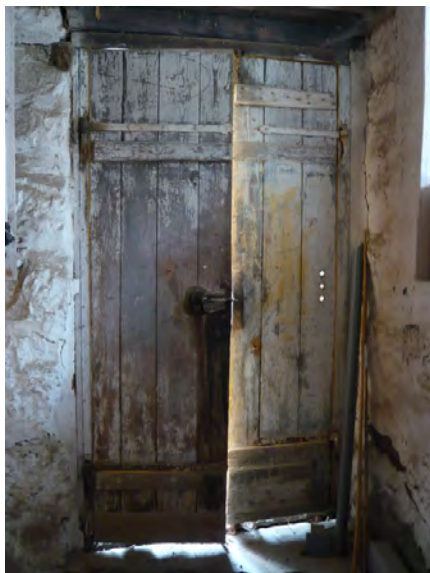
Dør til bryggerhus. Opphavsrett: Statsbygg.
