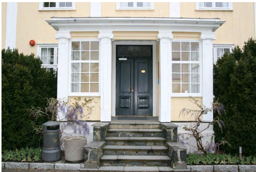
Inngangen vender mot syd ut mot dammen. Opphavsrett: Statsbygg.
