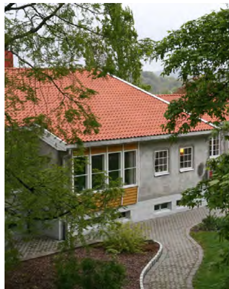
Fasade mot syd. Opphavsrett: Statsbygg.
