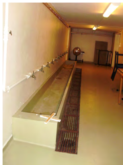
Støvelvask i kjelleren. Opphavsrett: Statsbygg.
