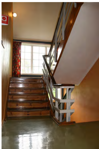
Trapp og trapperom. Opphavsrett: Statsbygg.
