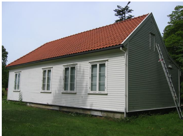
Fasade øst. Opphavsrett: Statsbygg.
