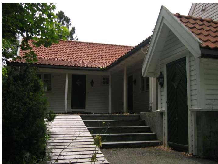
Fasader mot nord. Foto: Lasse Kaas Opphavsrett: Statsbygg.
