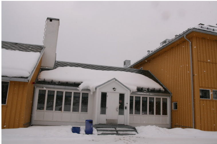
Tydelig definert inngangsparti som knytter boligdel og undervisningsbygg sammen. Opphavsrett: Statsbygg.
