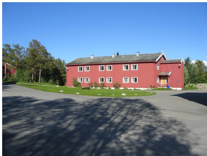
Fasade sørøst. Opphavsrett: Statsbygg.
