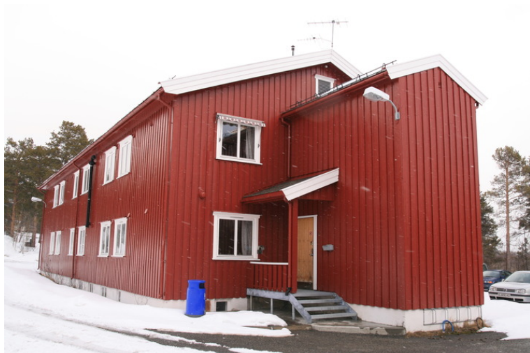
Internatet mot hovedadkomst. Opphavsrett: Statsbygg.
