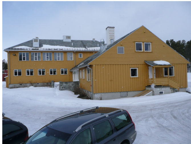
Opprinnelig boligdel til høyre i bildet. Opphavsrett: Statsbygg.
