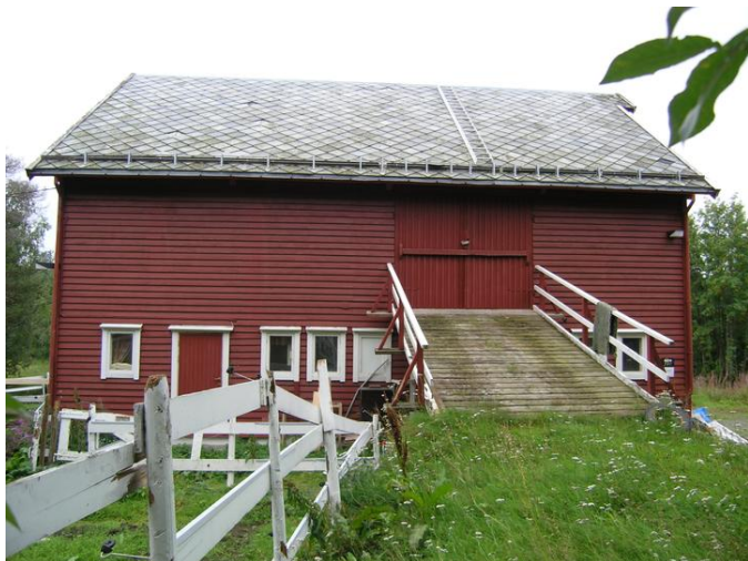
Fasade øst. Opphavsrett: Statsbygg.
