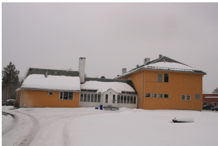
Gamle husmorskolen. Opphavsrett: Statsbygg.
