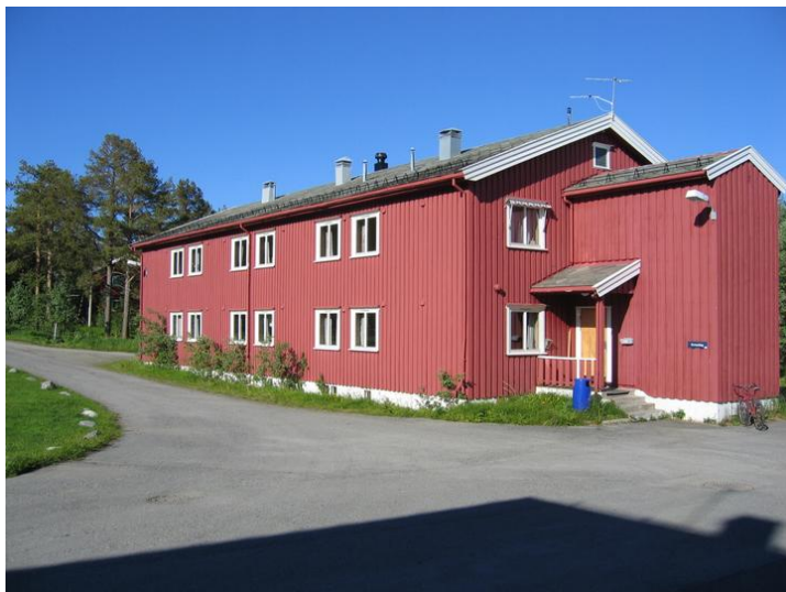
Fasade sørøst litt nærmere. Opphavsrett: Statsbygg.
