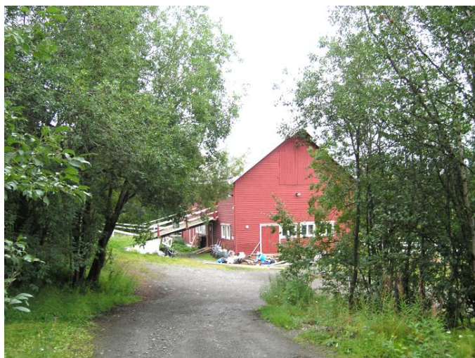
Adkomst fra internatet. Opphavsrett: Statsbygg.
