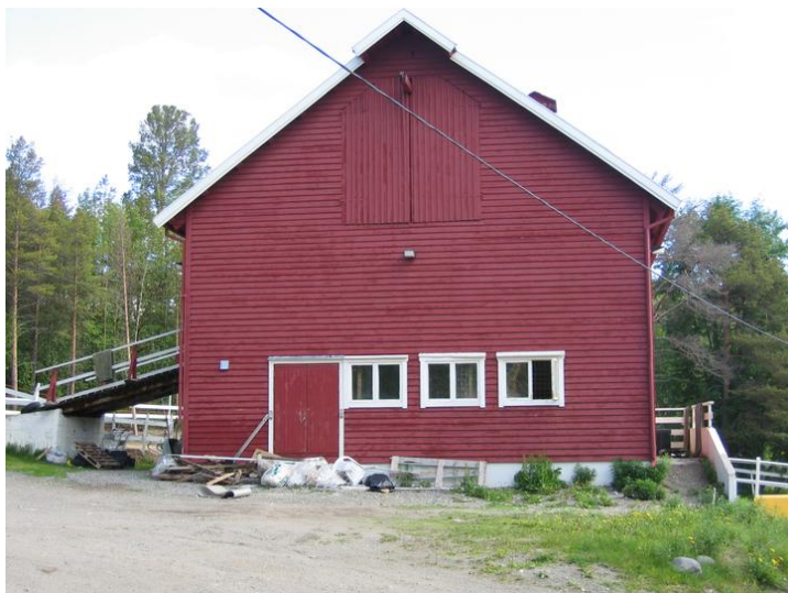
Fasade mot nord(øst) Opphavsrett: Statsbygg.
