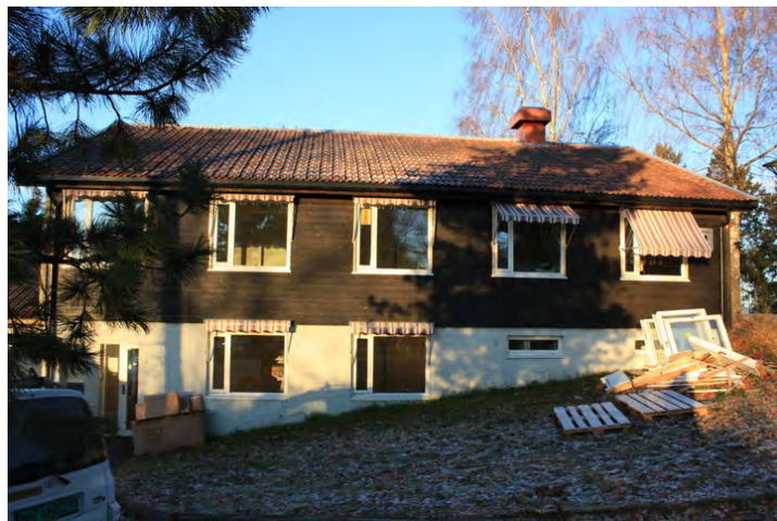
Fasade mot syd Opphavsrett: Statsbygg
