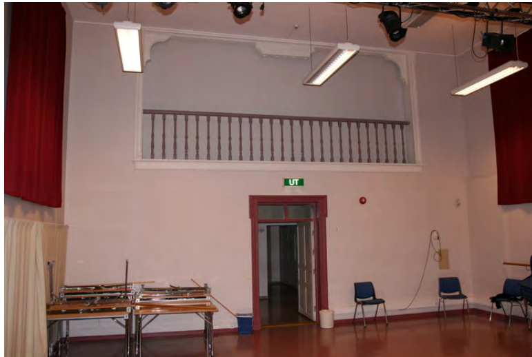
Galleri i gymsal. Opphavsrett: Statsbygg.
