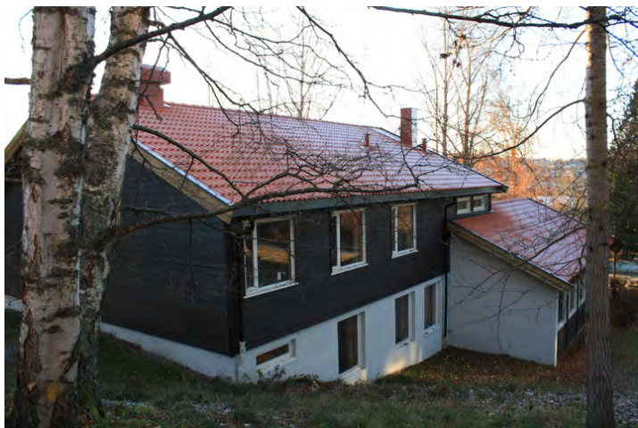
Fasade mot øst Opphavsrett: Statsbygg
