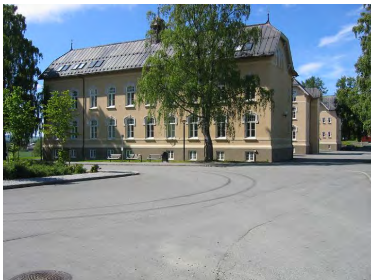
Østfasade. Opphavsrett: Statsbygg.
