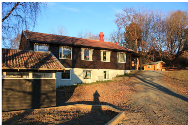
Fasade mot syd. Opphavsrett: Statsbygg.
