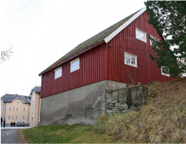
Fasader mot nord og vest. Stabburet står på tett betongmur. Opphavsrett: Statsbygg.
