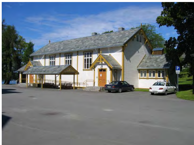
Sør- og østfasader. Opphavsrett: Statsbygg.
