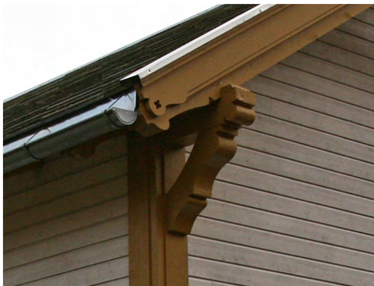
Detalj bjelkehoder. Opphavsrett: Statsbygg.
