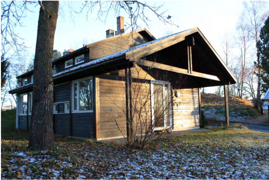
Fasade mot øst Opphavsrett: Statsbygg
