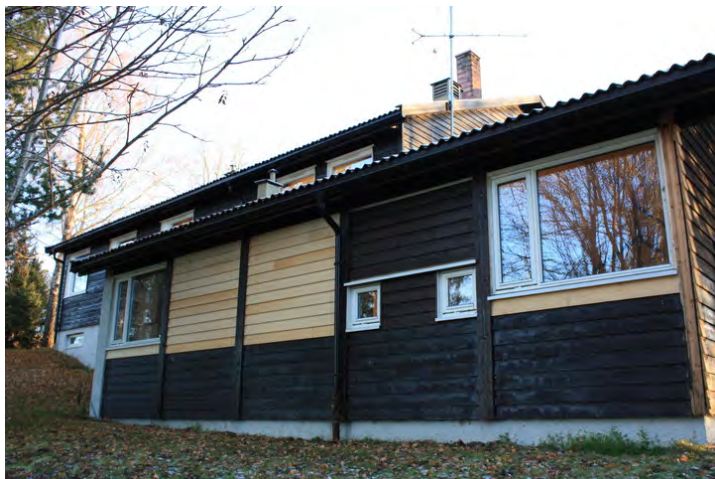
fasade mot nord Opphavsrett: Statsbygg
