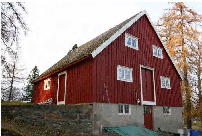
Stabburet med fasader mot sør og øst. Opphavsrett: Statsbygg.
