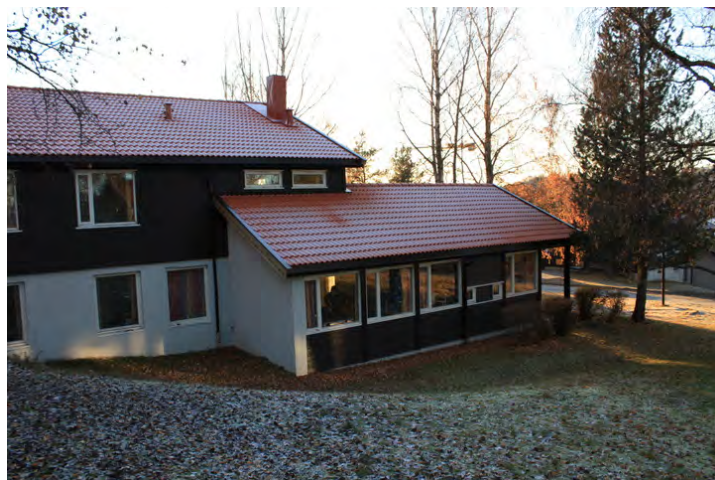
Fasade nord Opphavsrett: Statsbygg
