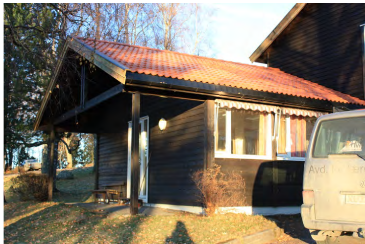
Fasade mot syd Opphavsrett: Statsbygg
