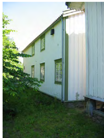
Nordfasade. Opphavsrett: Statsbygg.
