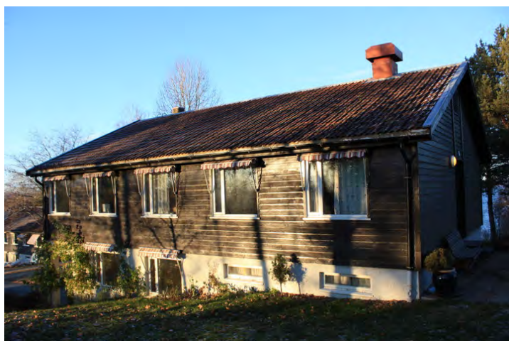
Fasade mot syd Opphavsrett: Statsbygg
