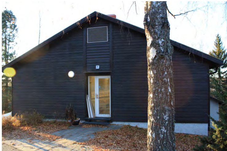
Fasade mot øst Opphavsrett: Statsbygg
