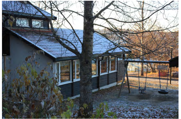
Fasade mot nord. Opphavsrett: Statsbygg.
