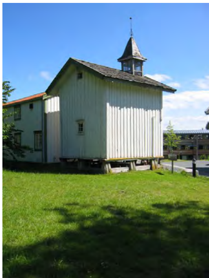
Fasader nord-vest. Opphavsrett: Statsbygg.
