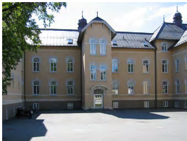
Inngangspartiet i nord-fasaden. Opphavsrett: Statsbygg.
