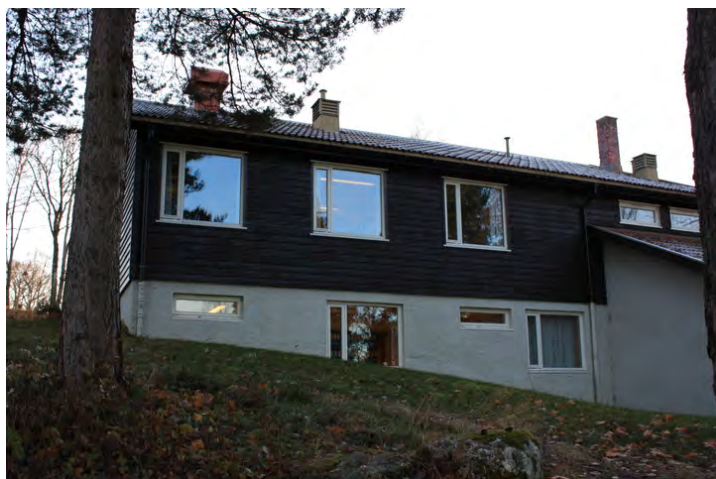
Fasade mot nord Opphavsrett: Statsbygg
