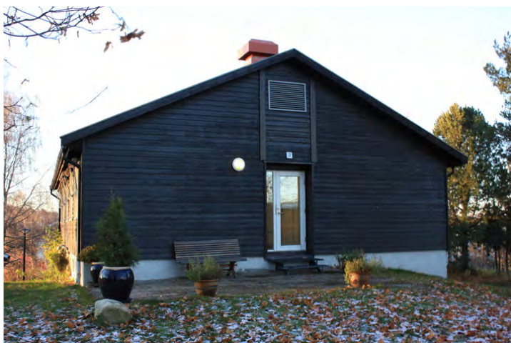
Fasade mot øst Opphavsrett: Statsbygg
