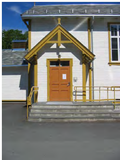
Inngangsparti med nyetablert rampe. Opphavsrett: Statsbygg.
