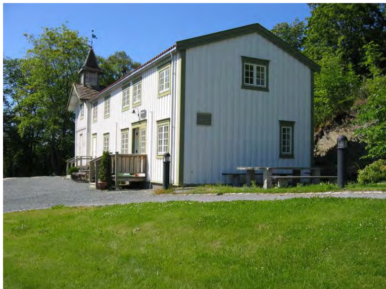
Sør- og østfasader. Opphavsrett: Statsbygg.
