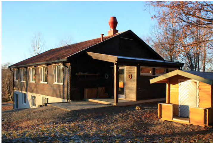
Fasade mot øst. Opphavsrett: Statsbygg.
