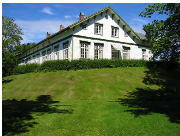
Vest- og sørfasader. Opphavsrett: Statsbygg.
