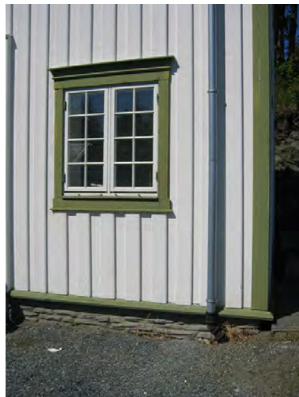
Detalj av vegg. Nyere vinduer. Opphavsrett: Statsbygg.
