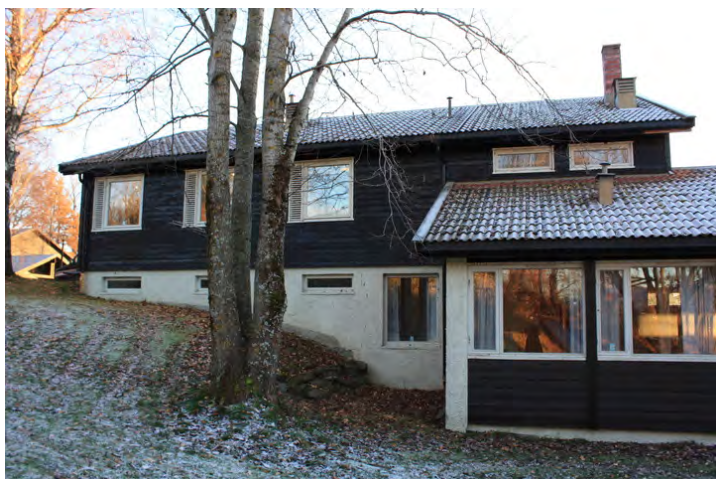
Fasade nord. Opphavsrett: Statsbygg.
