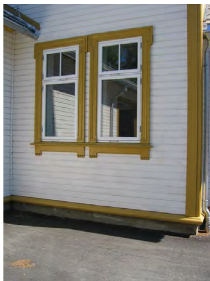
Veggdetalj med jugendpreget vindusomramming. Opphavsrett: Statsbygg.
