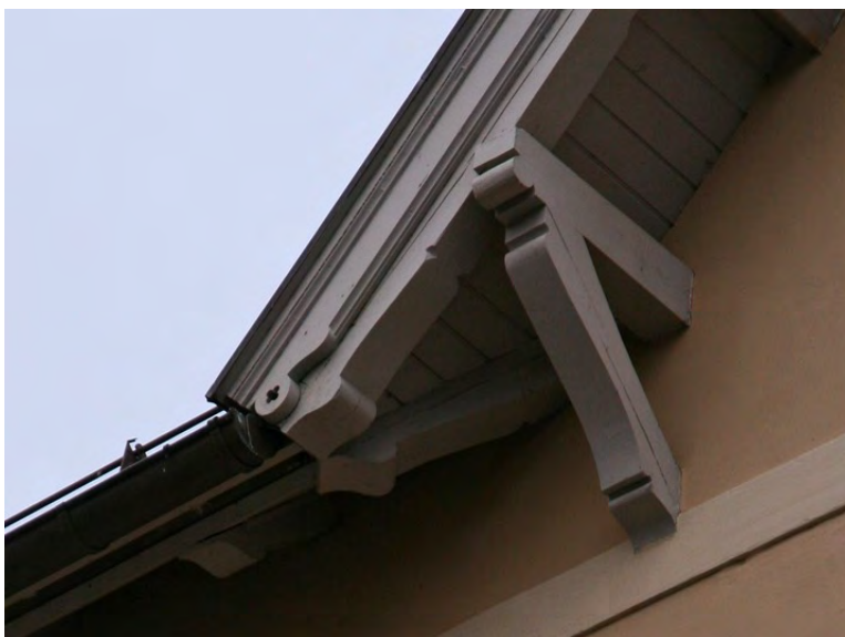
Detalj bjelkehoder. Opphavsrett: Statsbygg.
