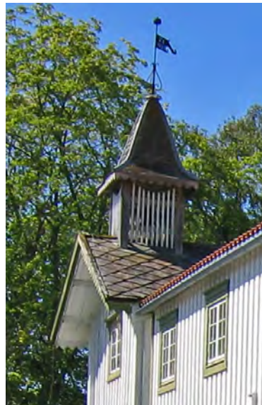
Klokketårn og skifertak. Opphavsrett: Statsbygg.
